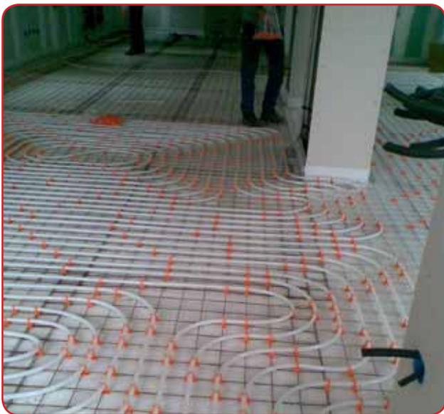
Figura 6: Sistema a pannelli radianti.
