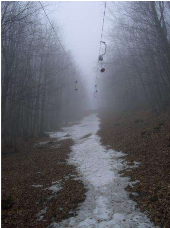
Figura 15 – Impianto di risalita presso la pista da sci sotto il Monte Falco
