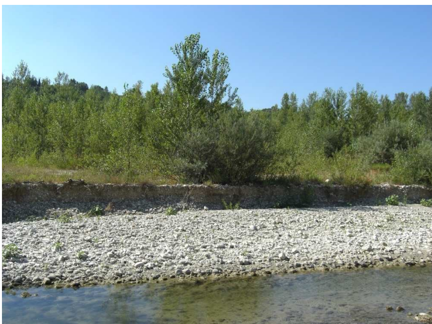
FIGURA 7 – EROSIONE IN SPONDA DESTRA DEL FIUME MARECCHIA.
