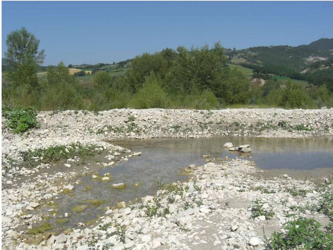
FIGURA 5 – SBARRAMENTO SUL TORRENTE MESSA.
