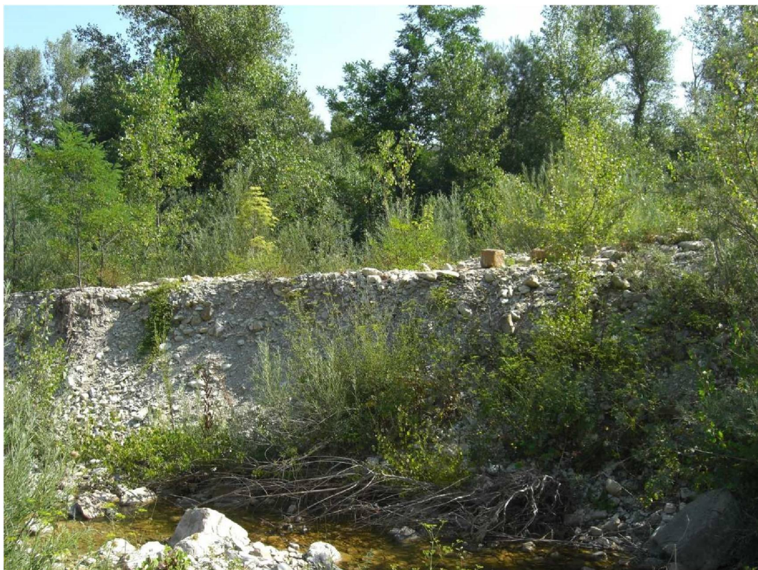
FIGURA 11 – EROSIONE IN SPONDA DESTRA DEL TORRENTE MESSA.
