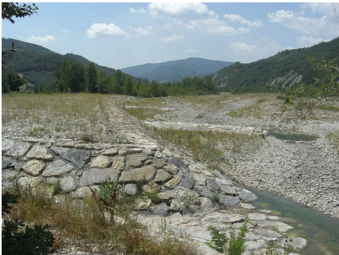
FIGURA 6 – DIFESA IDRAULICA IN SPONDA DESTRA DEL MARECCHIA.
