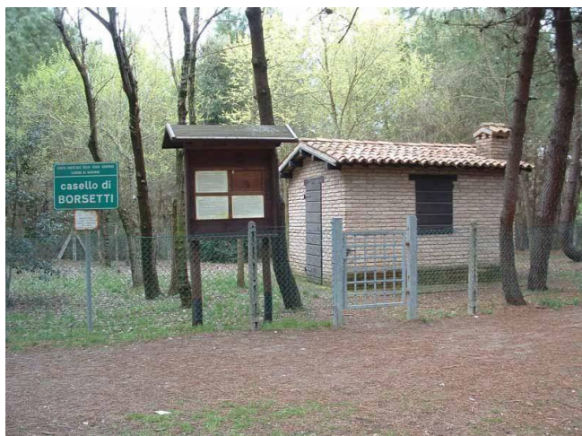
FIGURA 89 - CASELLO DI BORSETTI
