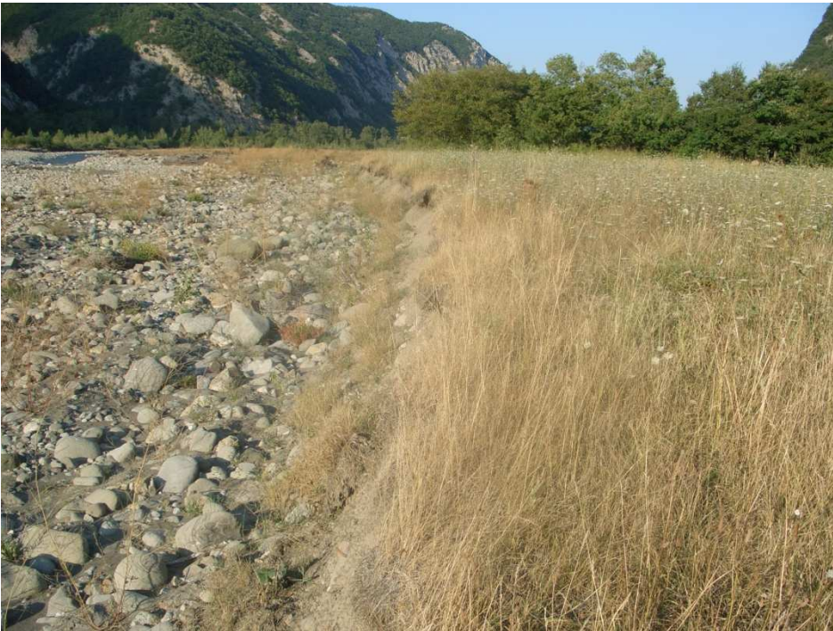
Figura 9 – Sponda in erosione in prossimità del Molino di Porcile
