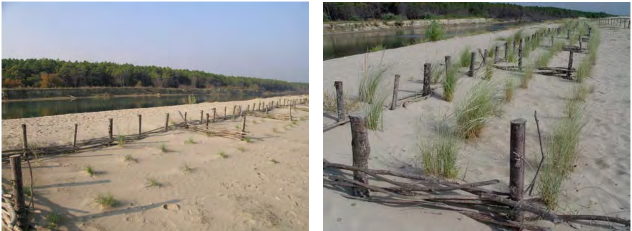
Figura 7 – Foce Bevano: sviluppo raggiunto dalla copertura vegetale dopo 8 mesi dall'impianto (foto a destra). L'impianto è stato realizzato il 26 ottobre 2006; la foto di sinistra è del 26 novembre 2006, la foto di destra è del 22 giugno 2007.
