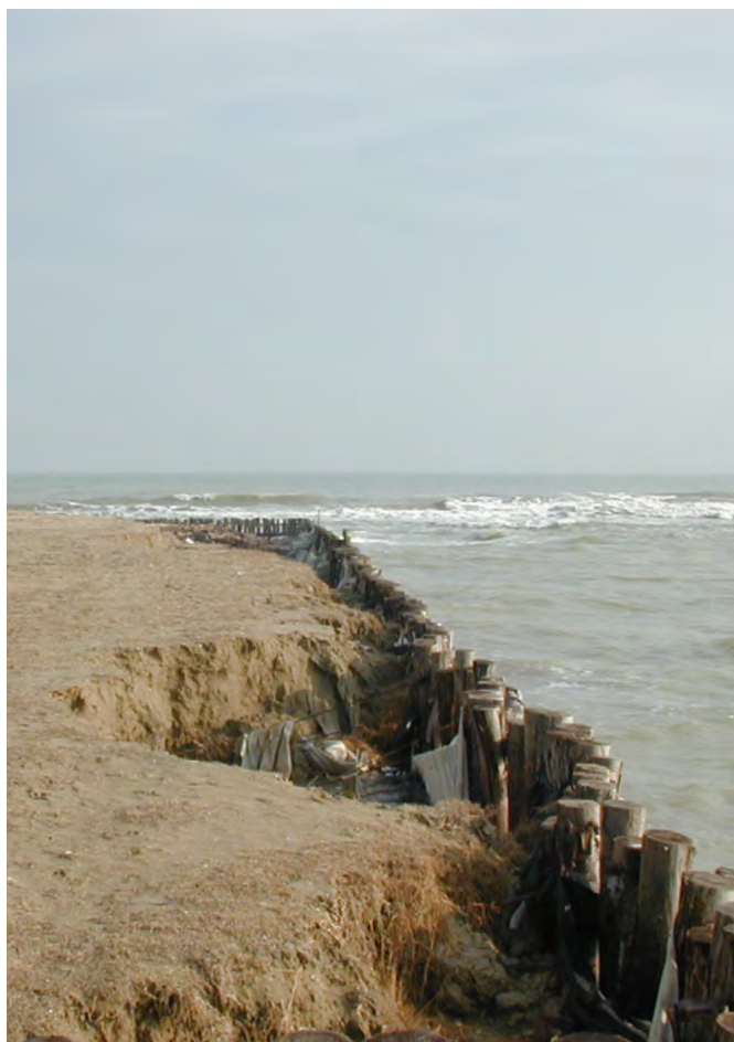
Figura 64 Fenomeni erosivi a tergo della palizzata a seguito di eventi estremi di mareggiata.
