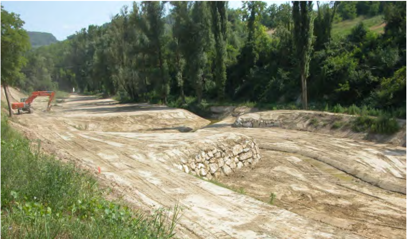
Figura 63 Esempio di sistemazione di un tratto ad area di laminazione.
