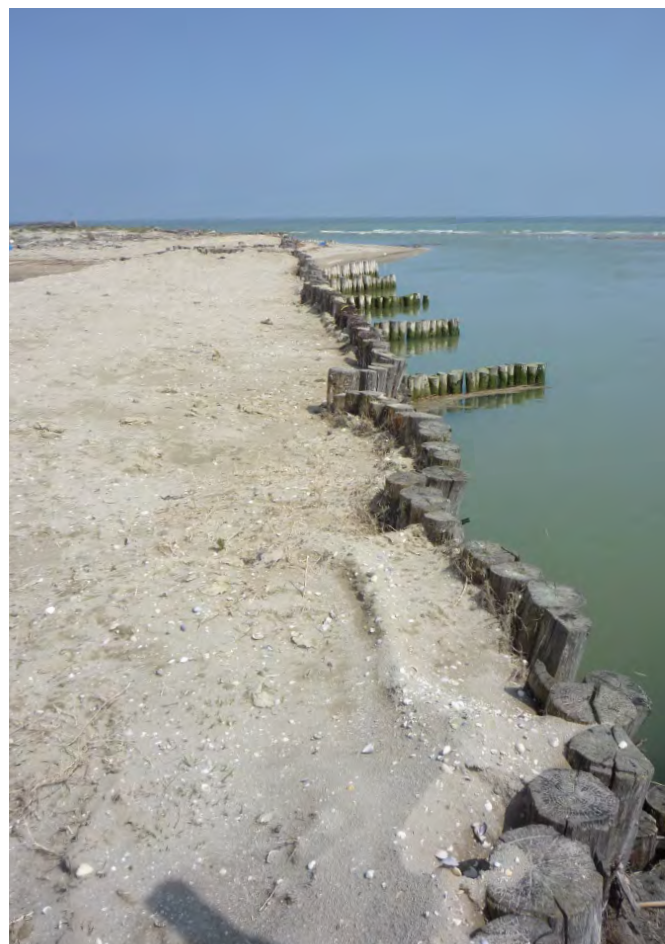
Figura 65 Sistemazione dell'area retrostante i pennelli in sinistra idraulica (manutenzione aprile 2013).
