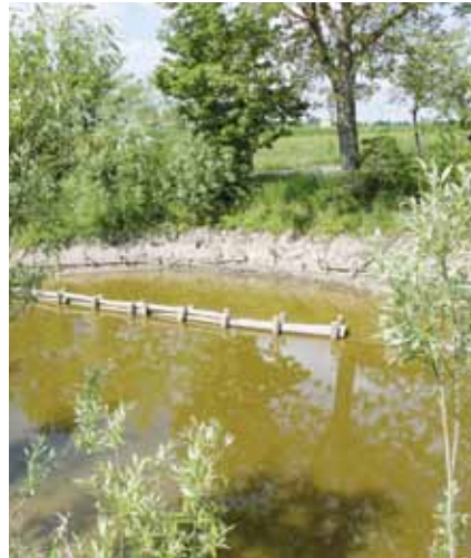
2 Creazione di habitat per anfibi. A sinistra: fasi intermedie dei lavori (dicembre 2004): creazione dello stagno tramite escavazione e approfondimento del sito; realizzazione di palizzate vive a sostegno della sponda e di palizzate morte tra il canale e lo stagno; copertura della sponda con inerbimento protetto da georete in cocco, fissata con talee di salice. A destra: lo stagno nel 2009, a 5 anni dalla fine dei lavori. Periodi eccessivi di riempimento del canale, realizzati per scopi irrigui in modo imprevisto e al di fuori di quanto stabilito in fase progettuale, hanno portato alla morte delle piante poste al di sotto del livello idrico raggiunto (ben visibile grazie al passaggio dalla parte nuda alla parte vegetata della sponda). Lo stagno rimane comunque ancora attivo e funzionale.
