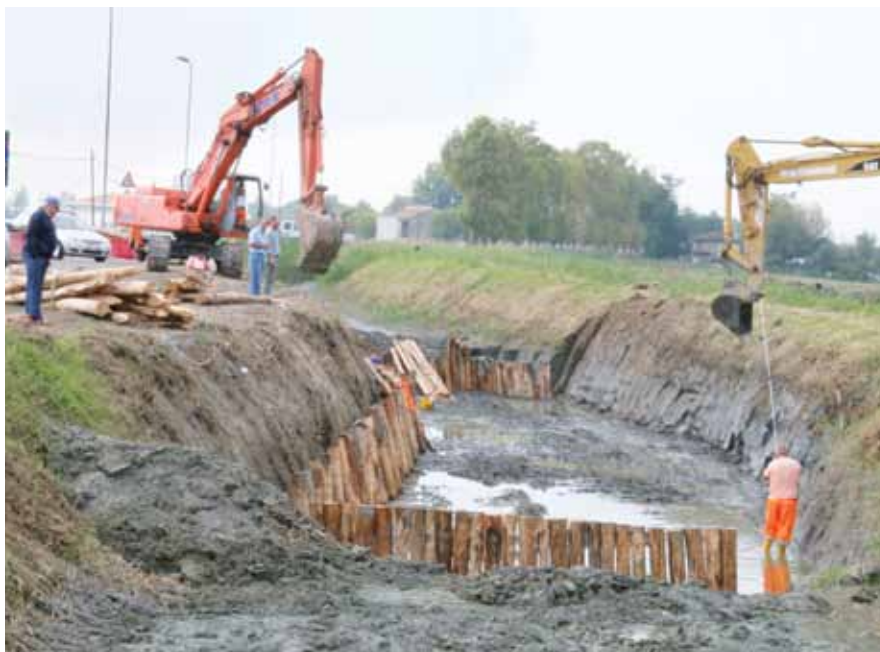
3 Trappola per sedimenti in fase di costruzione lungo il canale di San Giovanni, al termine dei lavori di abbassamento del fondo alveo (2009). In primo piano e sullo sfondo, prima e dopo lo scavo, il livello del fondo del canale, superiore a quello presente all'interno della trappola. Il perimetro dello scavo è protetto, nel caso in esame, da paleria di castagno, per evitare il franamento delle pareti della trappola.
