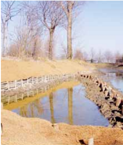
2 Creazione di habitat per anfibi. A sinistra: fasi intermedie dei lavori (dicembre 2004): creazione dello stagno tramite escavazione e approfondimento del sito; realizzazione di palizzate vive a sostegno della sponda e di palizzate morte tra il canale e lo stagno; copertura della sponda con inerbimento protetto da georete in cocco, fissata con talee di salice. A destra: lo stagno nel 2009, a 5 anni dalla fine dei lavori. Periodi eccessivi di riempimento del canale, realizzati per scopi irrigui in modo imprevisto e al di fuori di quanto stabilito in fase progettuale, hanno portato alla morte delle piante poste al di sotto del livello idrico raggiunto (ben visibile grazie al passaggio dalla parte nuda alla parte vegetata della sponda). Lo stagno rimane comunque ancora attivo e funzionale.
