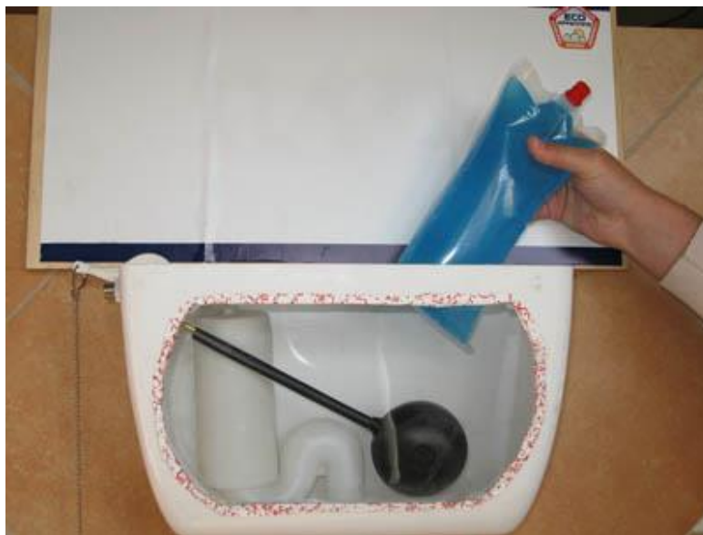
Installazione del sacchetto in una cassetta esterna
