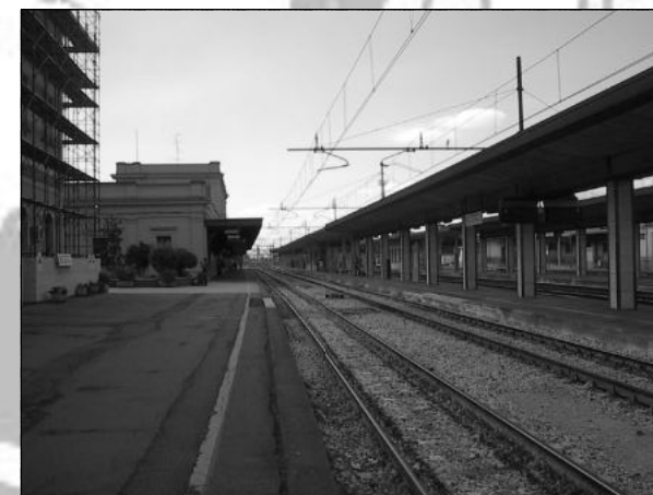
4. Marciapiedi con pensilina
