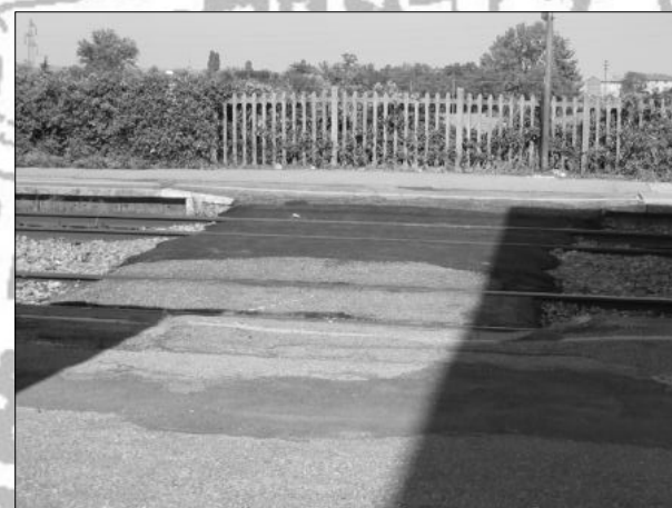
6. Passaggio a raso sui binari
