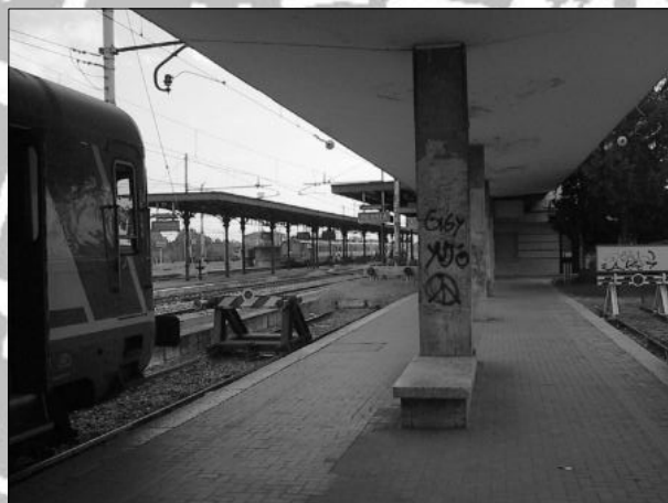
9. Binari piazzale ovest
