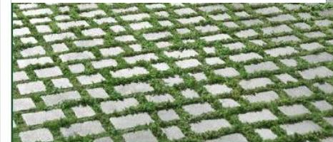
Sono blocchi in calcestruzzo con aperture a nido d'ape riempite con terreno organico e inerbite. La percentuale a verde supera il 40%. La pavimentazione viene posata su un sottostante strato portante in ghiaia mediamente di 20 cm di altezza e direttamente su un letto di pietrisco di 3-5cm di altezza. Sono adatti su parcheggi e strade d'accesso.
