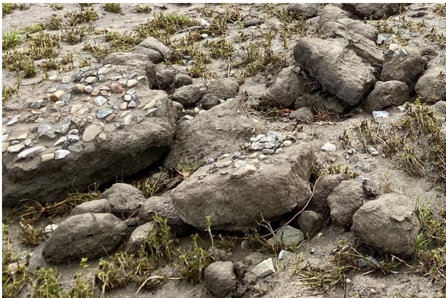
Figura 72 Blocchi della parte sommitale dell'argine con la pavimentazione stradale (foto di Paolo Simonini del 29/12/2020).
