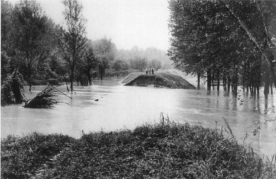
Figura 40 Una rotta dell'argine del Panaro del 1973 (Carnevali, 2017).
