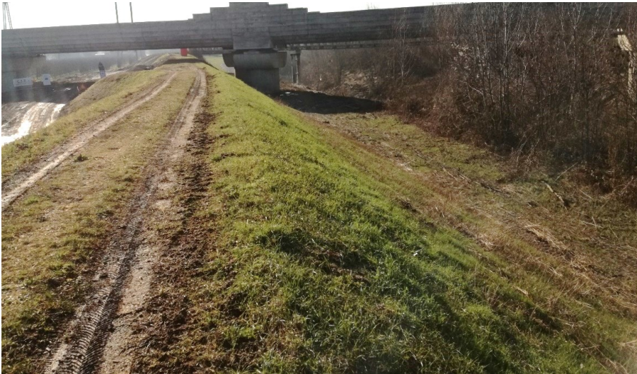
Figura 117. Argine destro del Panaro in prossimità dell'intersezione con la linea AV
