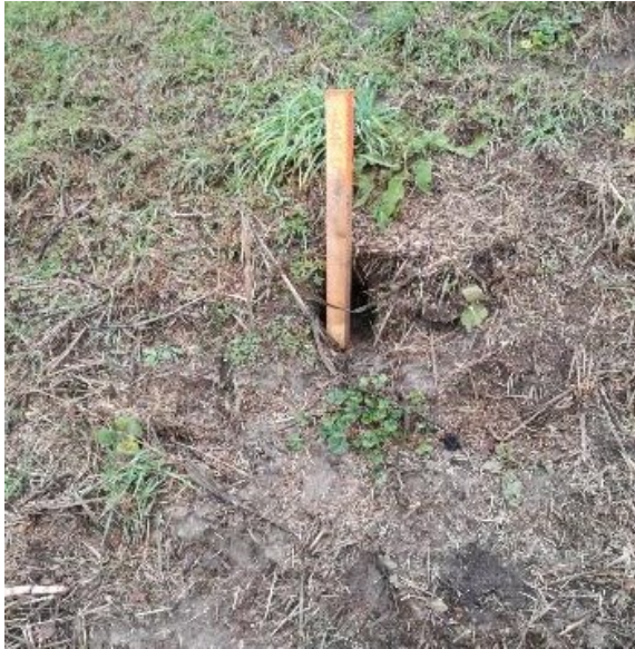
Figura 118. Perforazione posta sulla scarpata dell'argine destro in prossimità dello stante 31, lato campagna (a sinistra) e imboccatura di tana rinvenuta su scarpata argine sinistro, a circa 100 m a valle dello stante 31, lato campagna (a destra).
