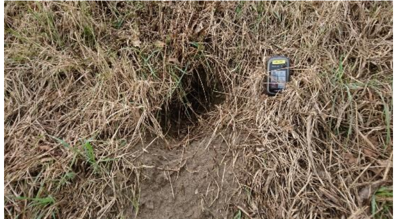
Figura 120. Perforazione su scarpata dell'argine destro a 50 m a monte dello stante 35 lato campagna (a sinistra) e relativo dettaglio (a destra).
