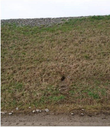
Figura 120. Perforazione su scarpata dell'argine destro a 50 m a monte dello stante 35 lato campagna (a sinistra) e relativo dettaglio (a destra).
