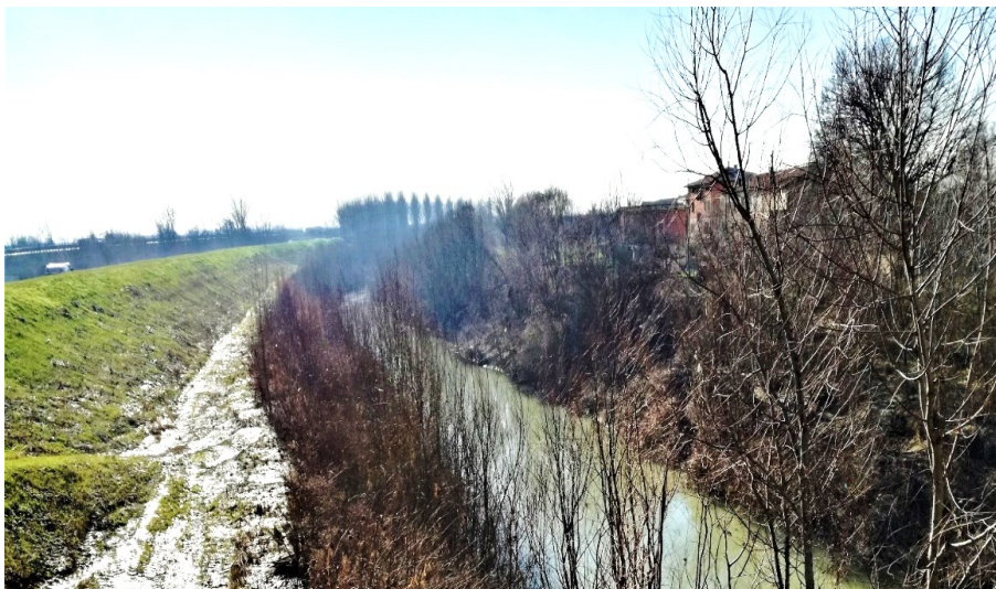
Figura 116. Conformazione dell'alveo fluviale del Panaro lato destro idrografico in prossimità del ponte di Navicello
