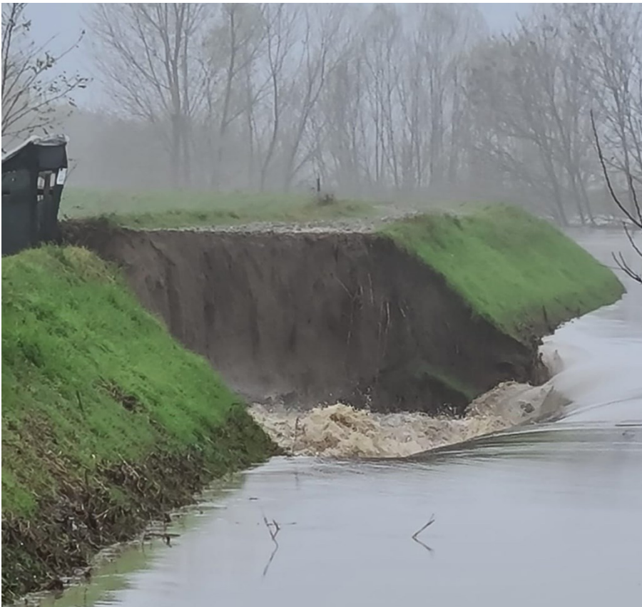
Figura 2. Immagine della rotta ripresa alle ore 8.30 del 6 dicembre, a oltre due ore dall'inizio del fenomeno. La larghezza della rotta è dell'ordine di una decina di metri. Si osserva bene, sull'argine, il massimo livello raggiunto dalla piena al momento del dissesto. Il piccolo casotto di caccia a sinistra nella foto crollerà a breve per erosione del piano di appoggio e sarà ritrovato nel ventaglio di rotta.
