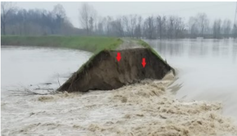
Figura 123. Immagine della sezione arginale in corrispondenza della rotta sull'argine destro del Panaro lato a monte.
