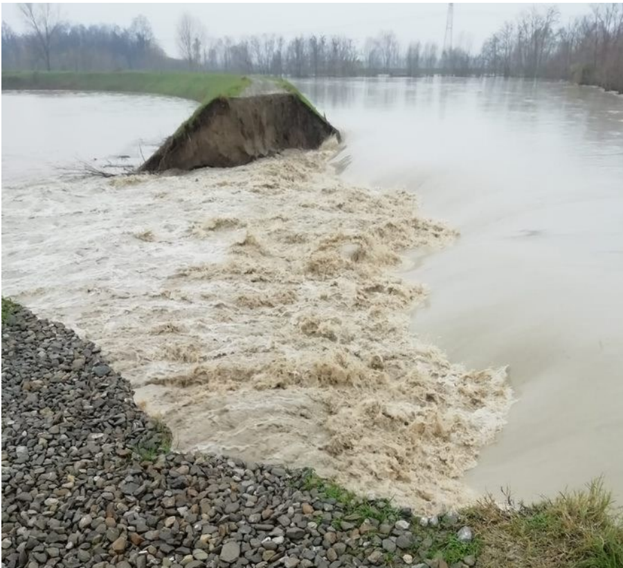
Figura 7. Evoluzione della rotta da immagine dei VVF ripresa alle 9:30 del mattino. Si nota la progressione della distruzione del rilevato rispetto all'immagine precedente.
