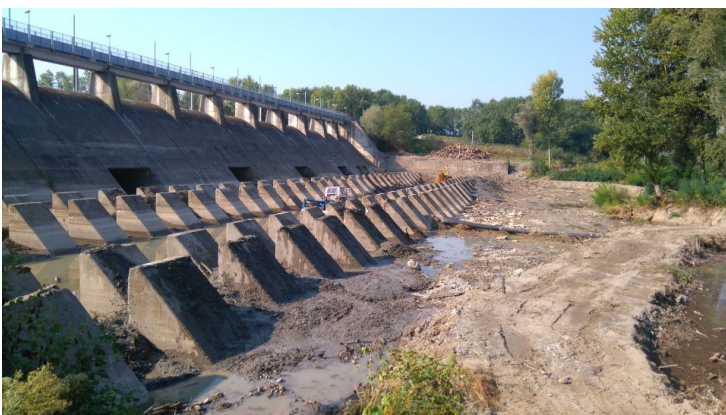
Figura 36. Cassa di espansione del Panaro; vista del manufatto moderatore da valle. In primo piano il sistema di dissipazione dell'energia dei getti provenienti dalle luci di fondo che si possono ben osservare sul paramento della traversa;
