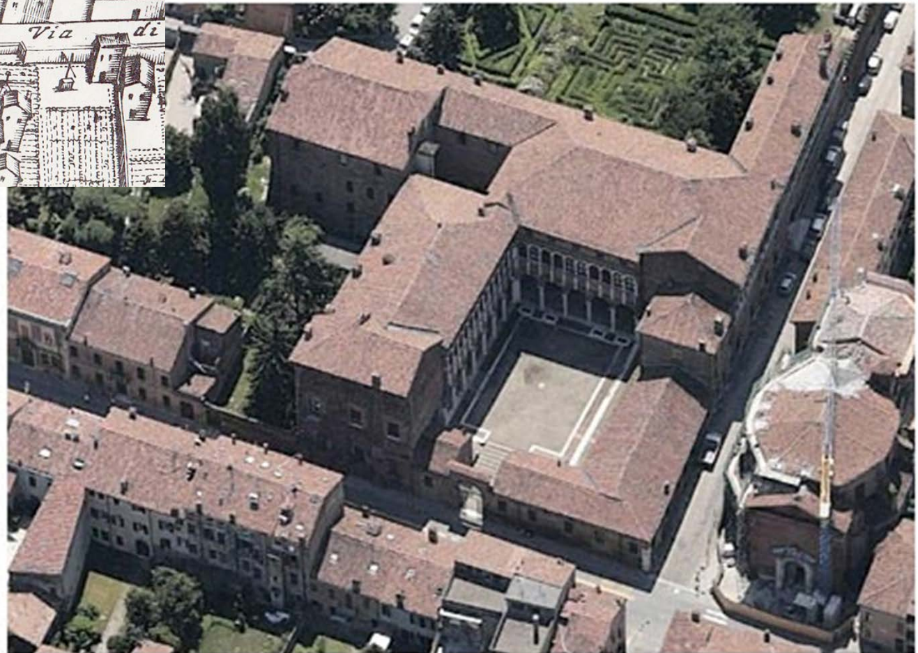
Struttura irregolare per planimetria , quote interne ed altezza dei corpi di fabbrica
