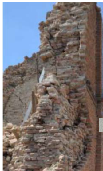
Muratura in mattoni ad due teste. Si tratta di due fodere sostanzialmente separate. Una delle due fodere, quella interna, si è distaccata.
