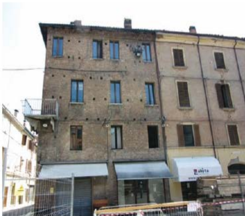
Mirandola : danno nelle fasce di piano
