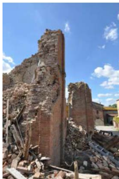
Muratura in mattoni ad due teste. Si tratta di due fodere sostanzialmente separate. Una delle due fodere, quella interna, si è distaccata.
