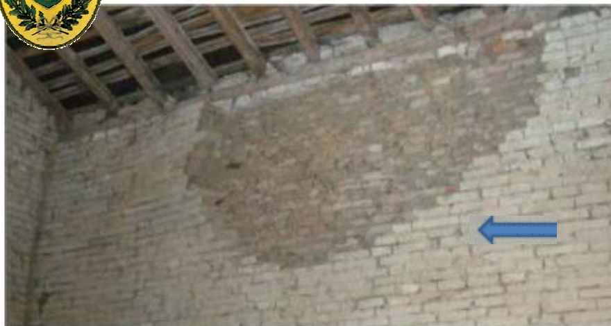
Muratura in mattoni ad due teste. Si tratta di due fodere sostanzialmente separate. Una delle due fodere, quella interna, si è distaccata.
