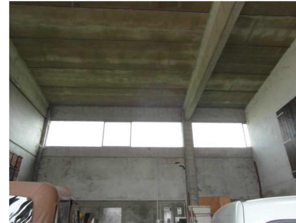
Presenza di elementi di tamponatura prefabbricati non adeguatamente ancorati alle strutture principali
