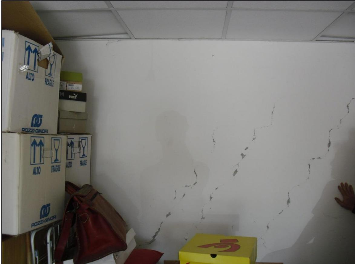
Tramezzatura al piano terra: collaborazione alla resistenza durante il sisma e quadro fessurativo diagonale (lieve)
