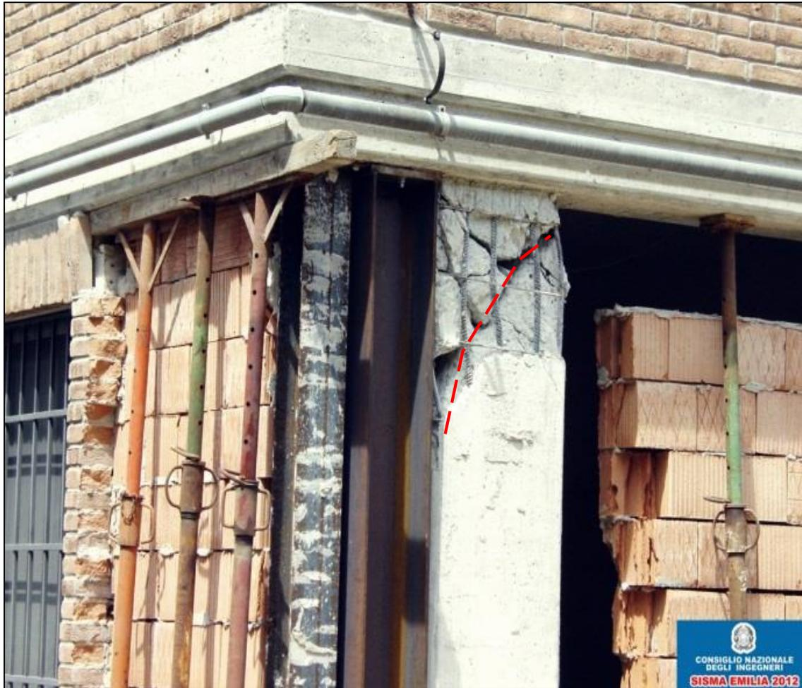
Crisi per taglio della sezione di estremità del pilastro
