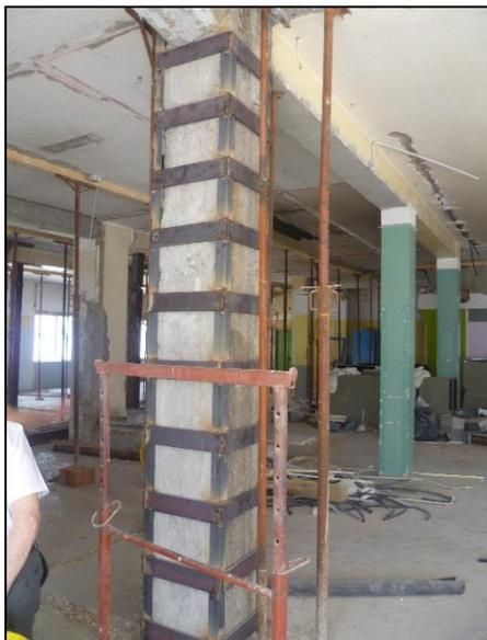
**Calastrelli metallici lungo lo sviluppo verticale del pilastro:** intervento a carattere discreto, ma con possibilità di assumere quote parte di sforzo normale agente sul pilastro
