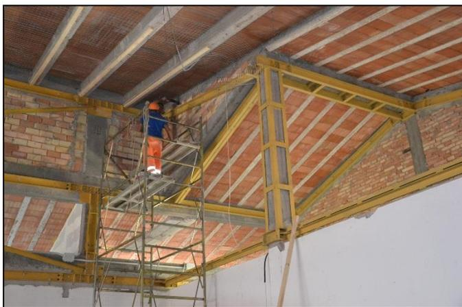
**Fasciatura in frp dei nodi e delle estremità dei pilastri:** fasciatura continua con conseguente incremento di taglio e resistenza a compressione del conglomerato.
