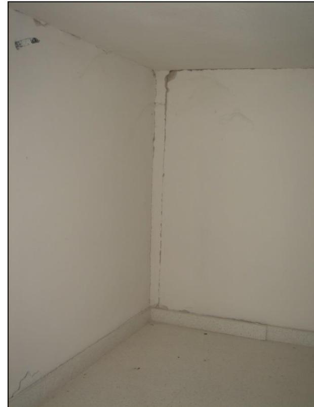
**Danni alle tramezzature interne e tracce lungo i bordi di contatti con solaio e pilastri (più estesi e rilevanti al piano terra e più lievi ai piani superiori)**
