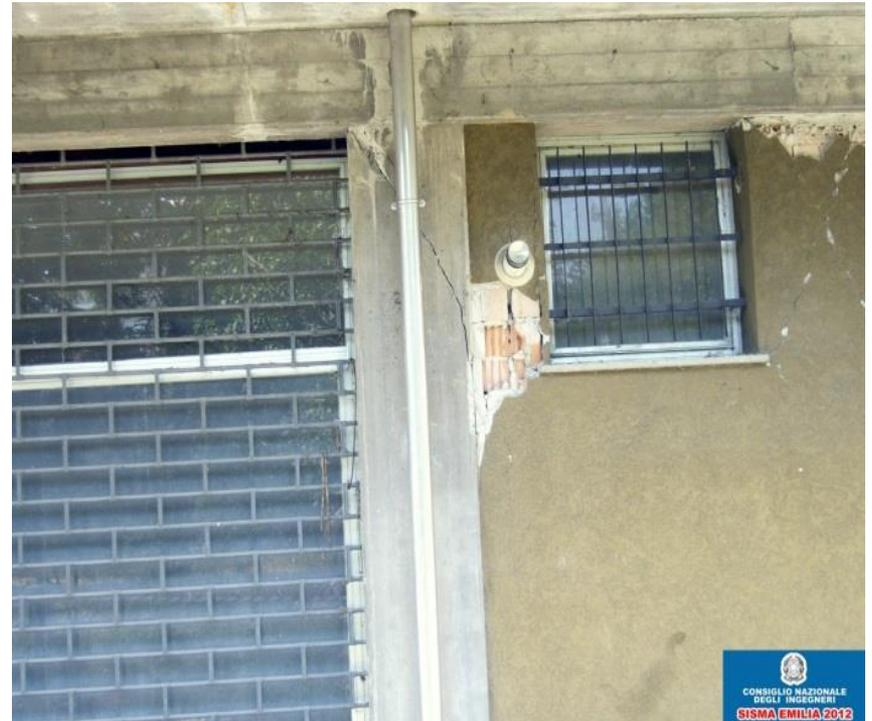
**Formazione di pilastro tozzo per parziale sviluppo lungo l'altezza delle murature**
