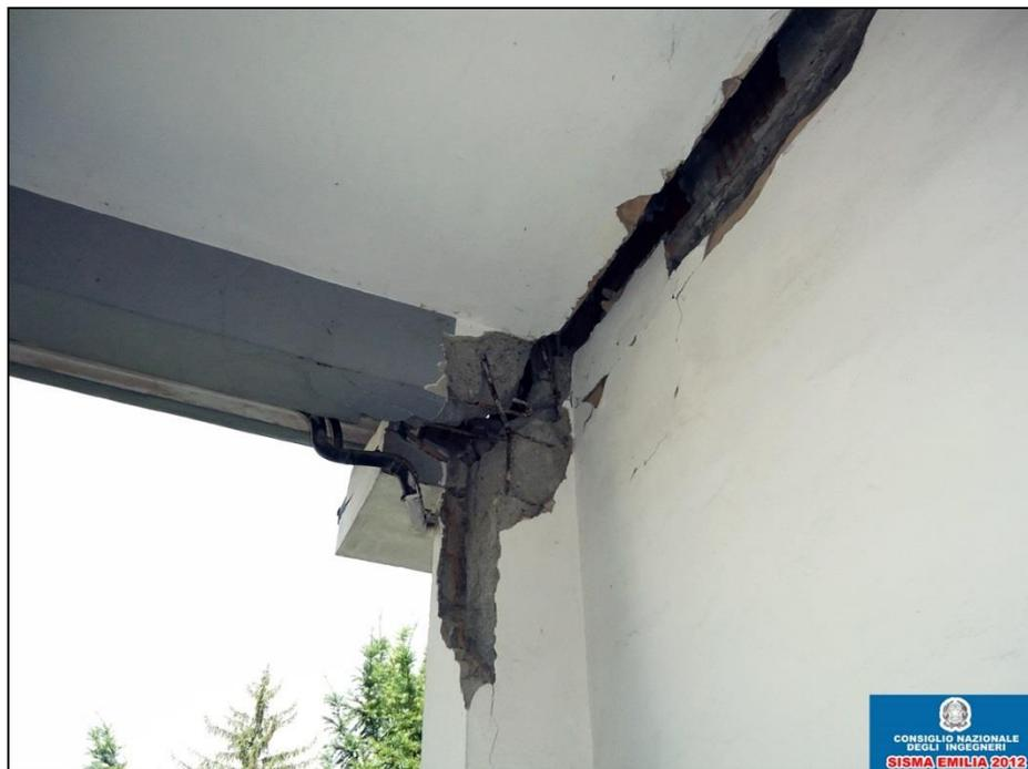
Danno su nodo di struttura a telaio in c.a.
