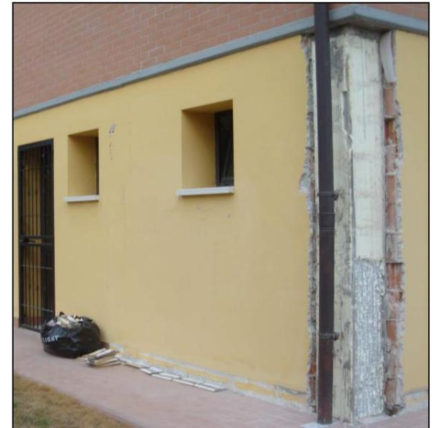
**Pilastro visionato tramite rimozione intonaco: completamente integro**
