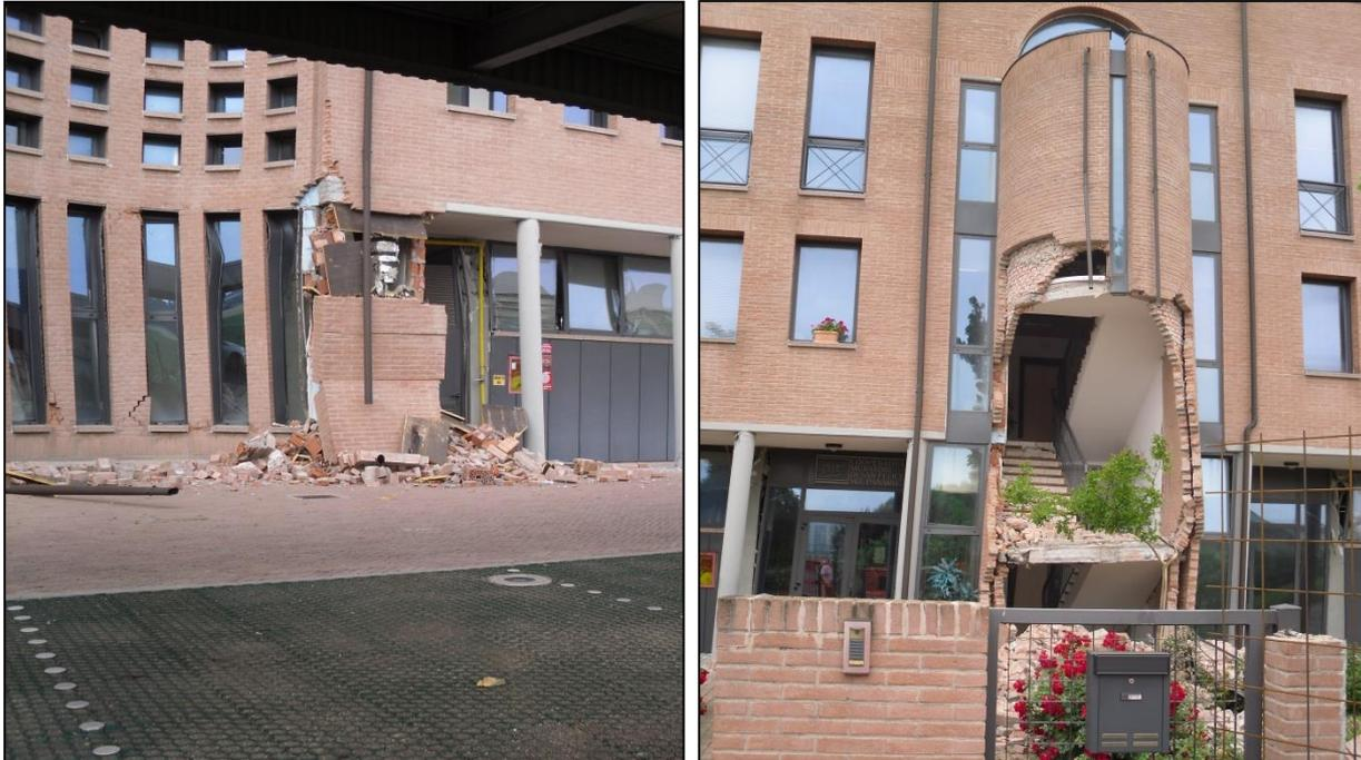
Crisi dei tamponamenti in seguito a forti richieste in termini di spostamento e deformazione
