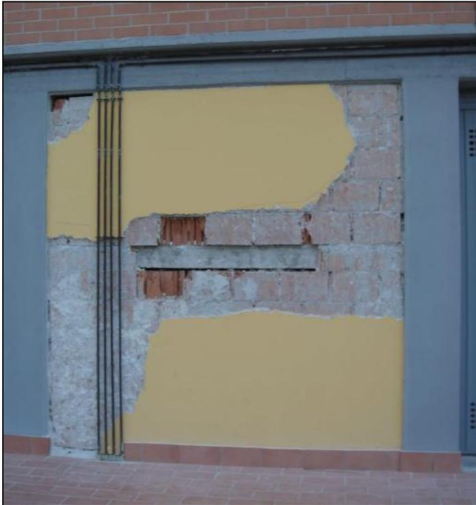
Danneggiamento locale della tamponatura esterna in presenza del pinaerottolo
