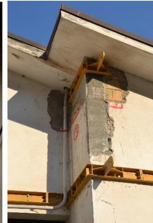
Setti esterni collegati alla struttura esistente per l'assorbimento delle azioni sismiche orizzontali
