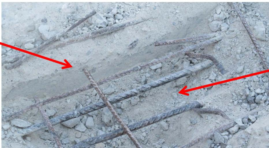
Solaio adiacente con massetto e rete che si fermano all'interfaccia con il tegolo
