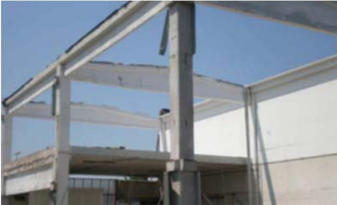
Esempio di crisi per perdita di appoggio della copertura.
