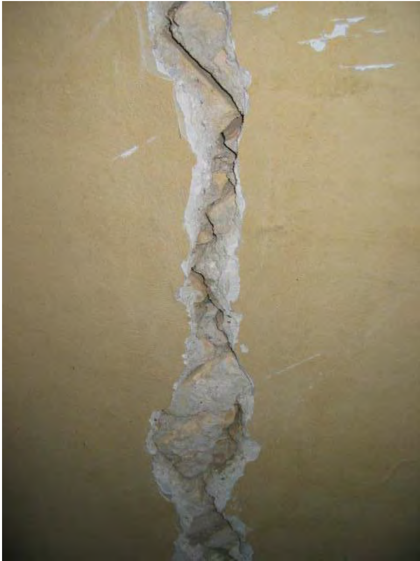
Particolare “cerniera” intradosso rampa
