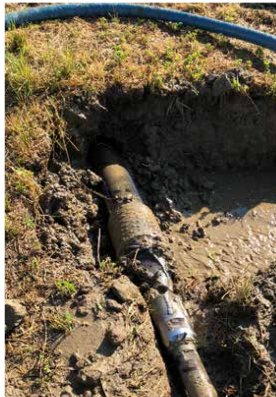
Figura 10. Fase di alesaggio e messa in opera Dreni Orizzontali (HD)
