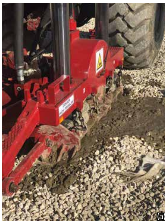
Figura 13. Liquefazione indotta al piano di lavoro nell'area di terreno non trattato (a), sezione con vista canali verticali di risalita di acqua e sabbia (b)
