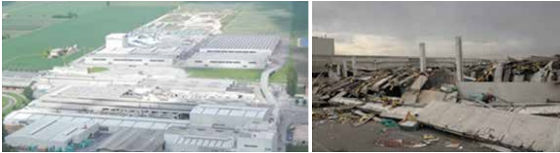
Figura 13. Esempi di edifici industriali tipo nell'area di studio (a) e di collasso osservato in seguito al sisma del 20 maggio 2012.
