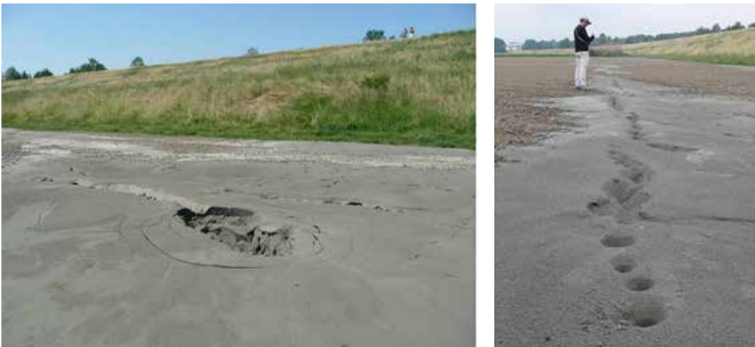
Figura 3. Liquefazione a seguito dei movimenti tellurici del maggio 2012 nell'area selezionata per i test
