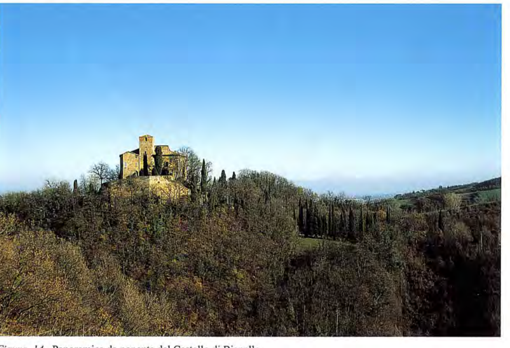
Figura 14 - Panoramica da sud del castello di Bianello.
