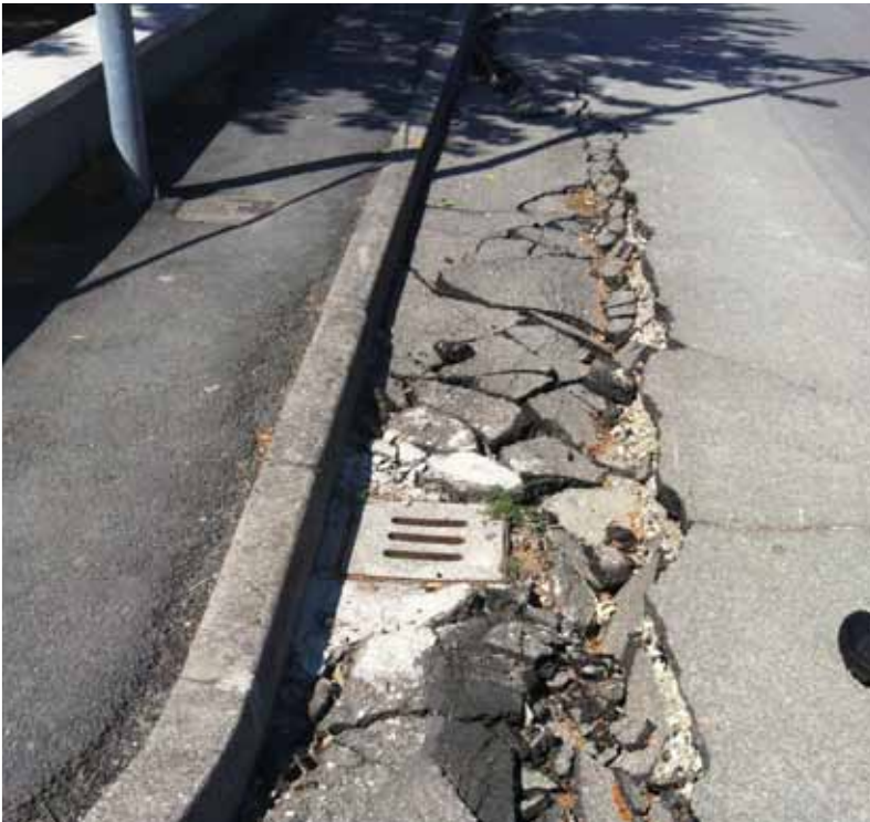
Effetti della liquefazione sulle infrastrutture.
