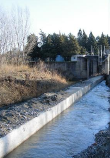
Opera di presa sul f. Marecchia
