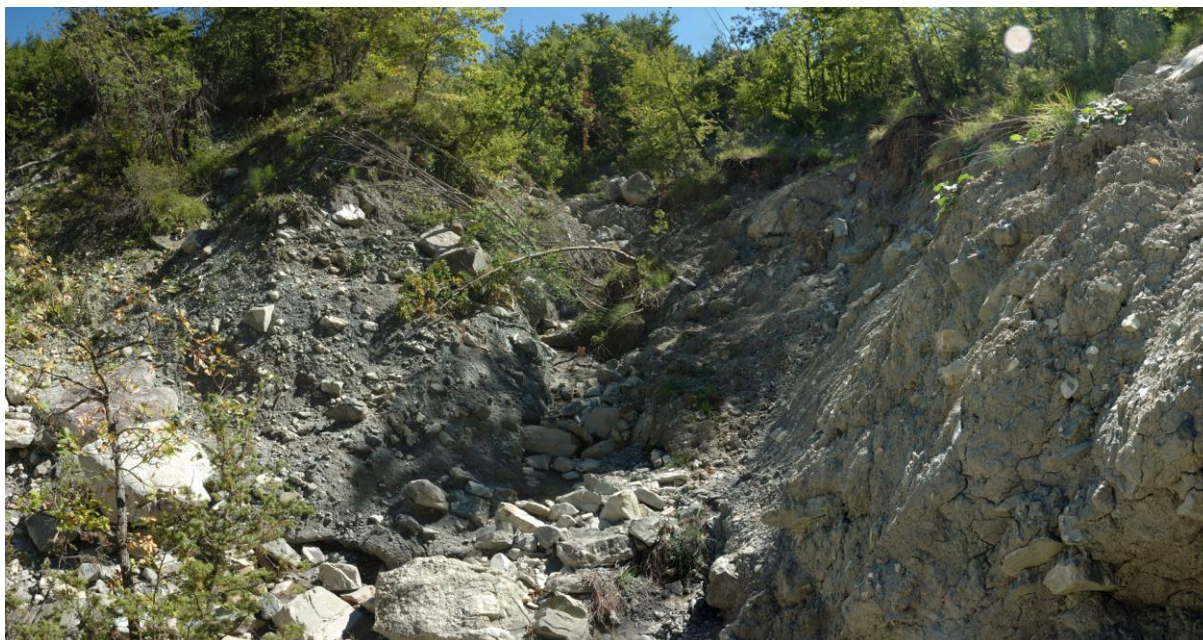
Figura 17 - Esempio di passaggio di una colata di detrito canalizzato su un substrato costituito da breccie poligeniche a matrice argillosa. Dopo il passaggio della colata di detrito, che ha profondamente eroso l'alveo, i versanti del torrente sono stati interessati da fenomeni tipo debris slide e conseguente intasamento del fondo da parte del relativo deposito.
