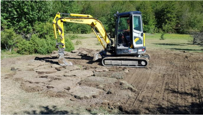
Fig.5: Operazioni di ripristino. A sinistra, il riposizionamento delle zolle erbose rimosse all'atto dello scavo, a destra l'aspetto finale.
