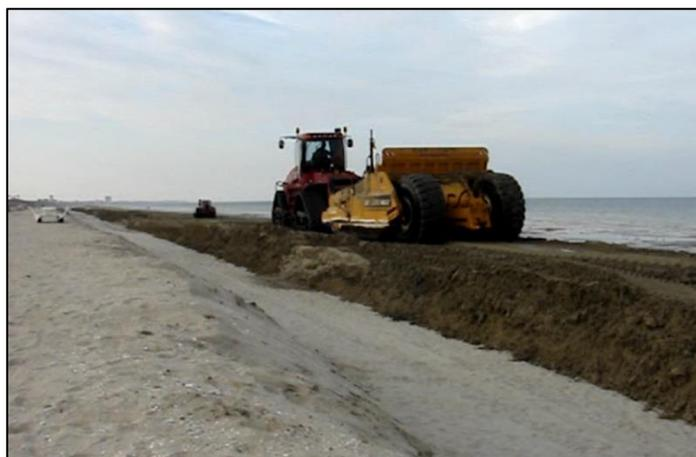
*Figura I.4.2-17: Attività di prelievo di sabbia dagli accumuli litoranei della spiaggia sommersa e redistribuzione in quella emersa tramite scrapers*
