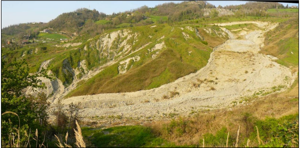
Fig. 38 : vista della nicchia del lobo settentrionale e della parte alta della frana di Montevecchio.
