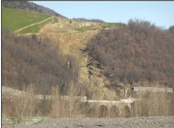
Fig. 46: panoramica sul dissesto di Ronco Puzzola, ripreso dal versante opposto.
