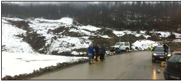
Fig. 34: immagine del piede della frana sulla SP 25 Massese (da www.Parmatoday.it )
