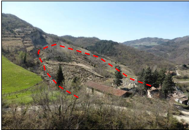
Fig. 54: panoramica sulla parte alta della frana.
