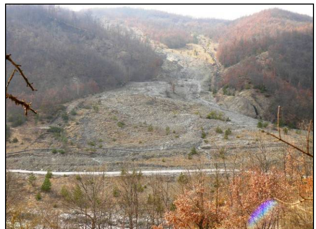
Fig. 18: immagine del piede della frana di Sassi Neri. Si notano la strada comunale, l'acquedotto comunale, esposto in superficie per evitare lesioni dovute al movimento franoso e in alto a destra il ramo settentrionale della frana oggetto in passato di sistemazioni idrauliche superficiali.
