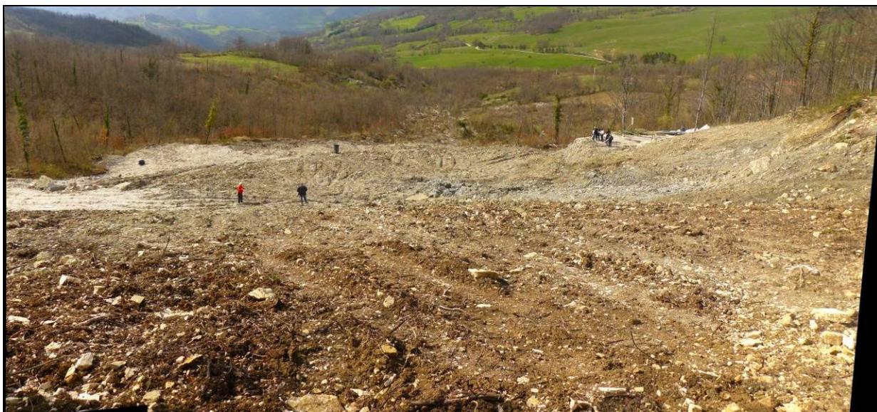
Fig. 15: vista della frana dal coronamento: la sede stradale è stata completamente asportata dal movimento.
