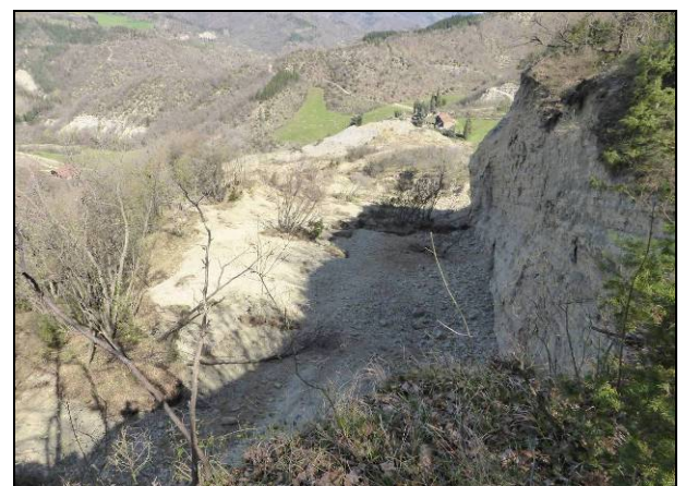
Fig. 53: in primo piano, in ombra, sono visibili il piano di scivolamento e la parete di neoformazione. In secondo piano l'accumulo e, sullo sfondo, il gruppo di case interessato.
