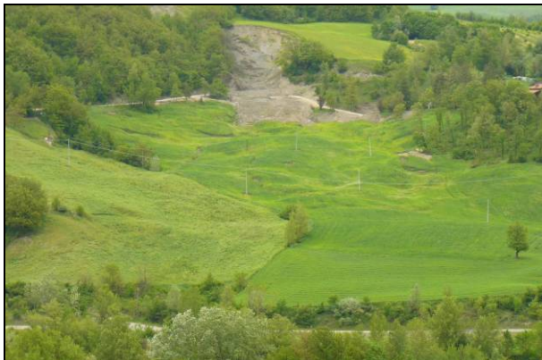
Fig. 36: vista della frana di Quercioli. Nella parte alta è visibile il terreno interessato da colate, nella parte bassa le aree interessate da scorrimento. La SP visibile nella parte bassa (non indicata nella fig.35) è interessata da fratture trasversali.
