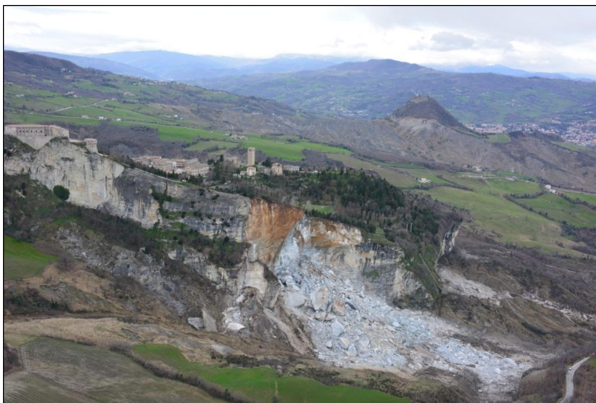
La frana di crollo di San Leo del 27 Febbraio 2013. (foto di Claudio Corrado Lucente)
