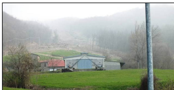
Fig. 22: vista del piede della frana di Torre Chiastre; in primo piano l'omonima località, posta pochi metri a valle del piede della riattivazione.
