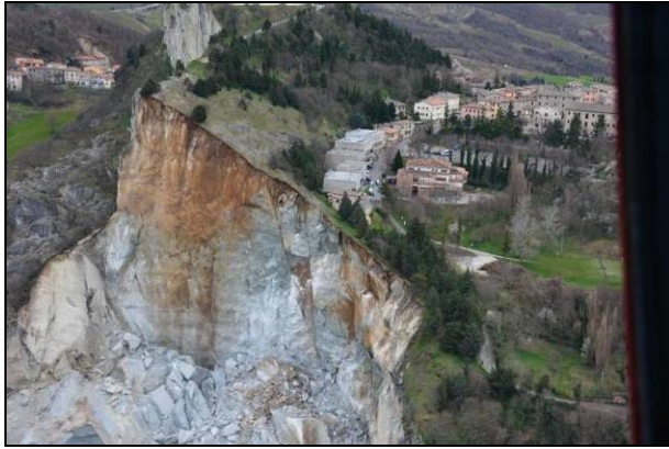
Fig. 50: immagine della parete franata e degli edifici sgomberati. (foto gentilmente concessa dal Servizio Tecnico di Bacino della Romagna).
