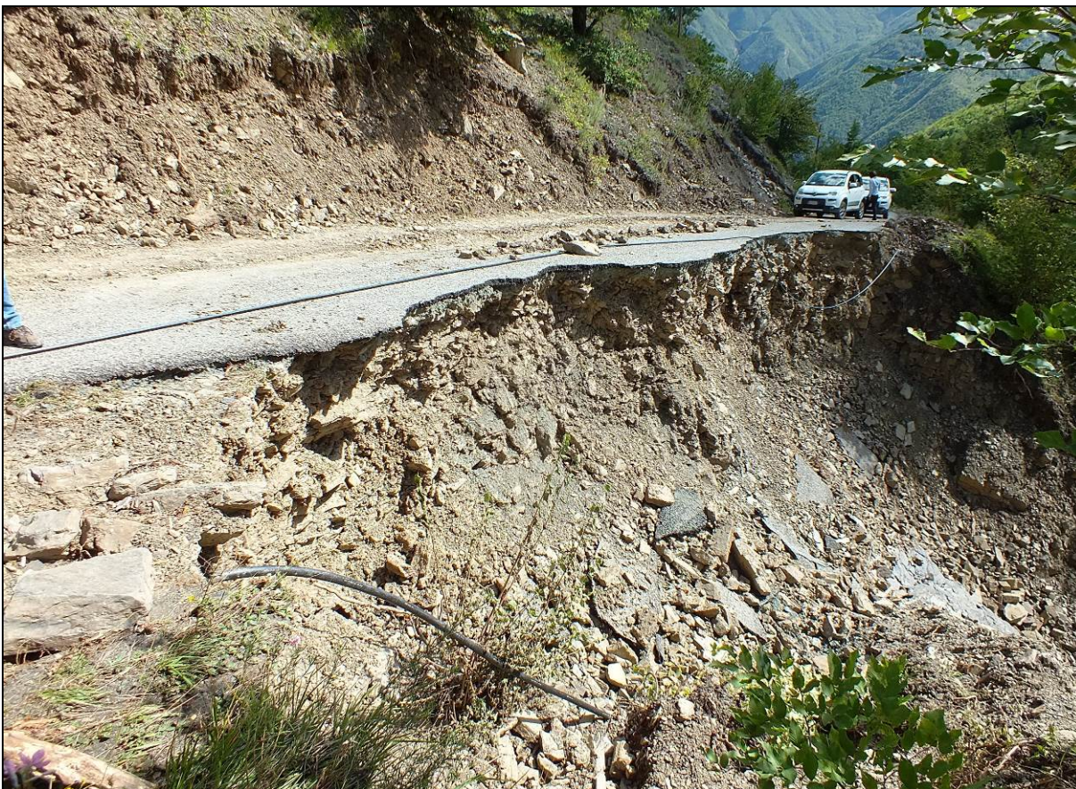
Fig. 51: effetti di smottamenti di detrito lungo la strada comunale di Lisore (Cerignale, PC).
