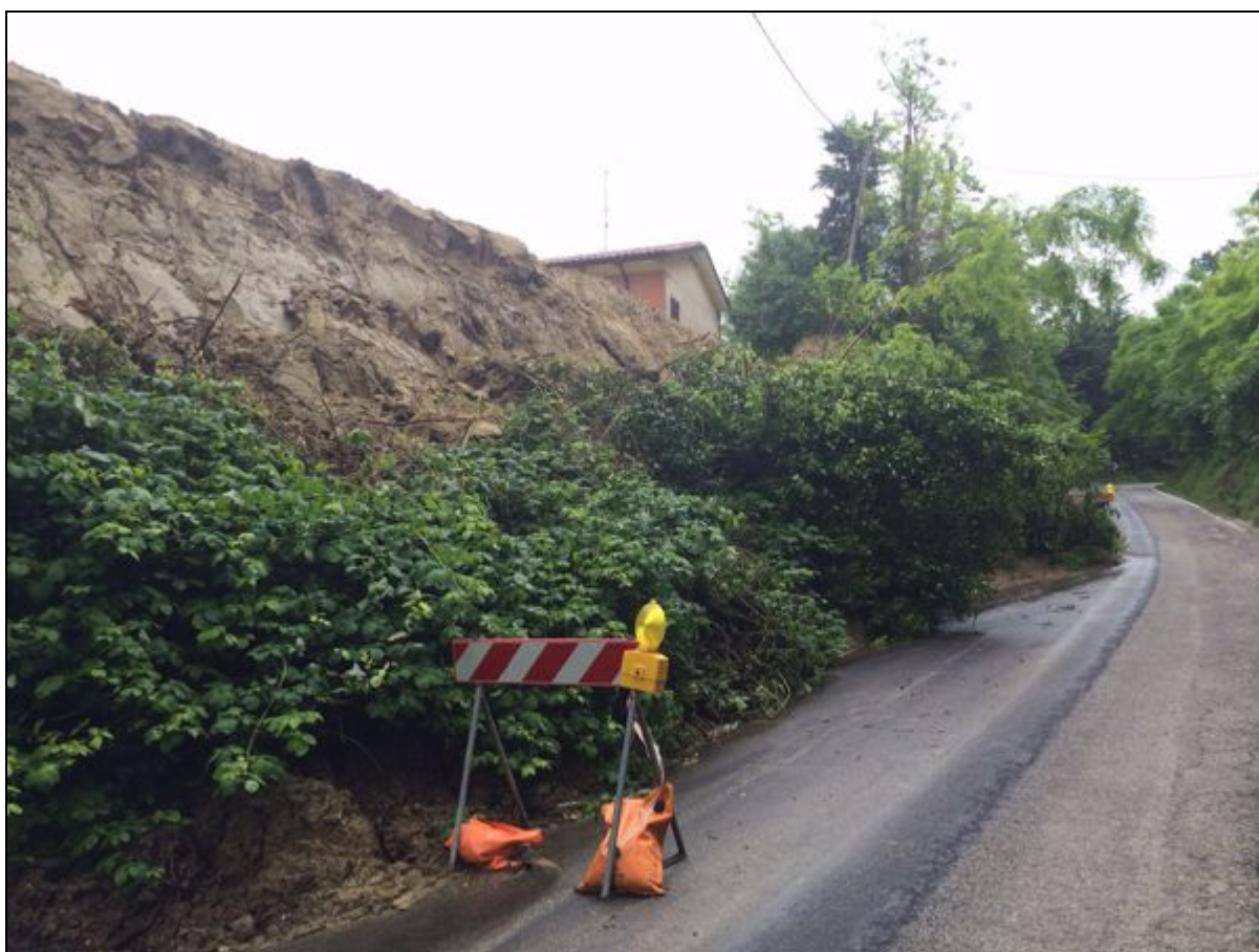
Fig. 46: smottamento a monte della via Garampa, in Comune di Cesena (FC), avvenuto il 26 Maggio 2015. (fonte: www.cesenatoday.it del 27 Maggio 2015).
