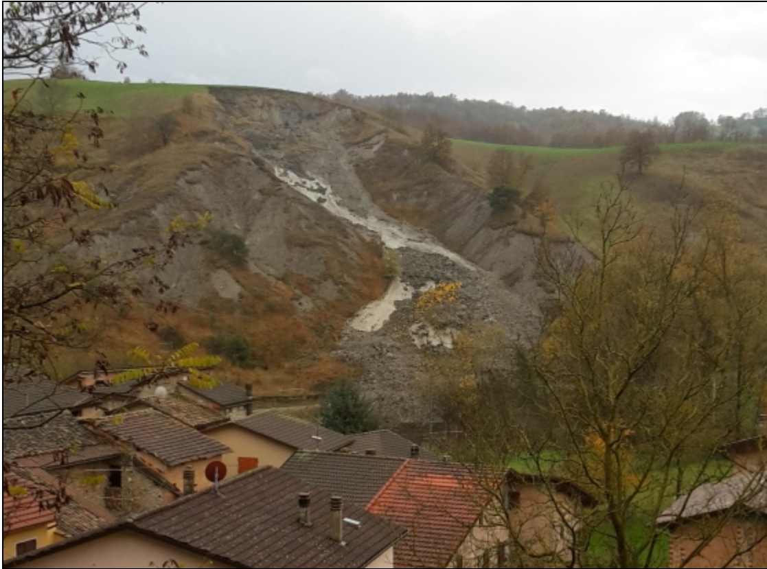
Fig. 7: panoramica della frana di Molino Cortogno (fonte: http://gazzettadireggio.gelocal.it/ del 14 Novembre 2014).
