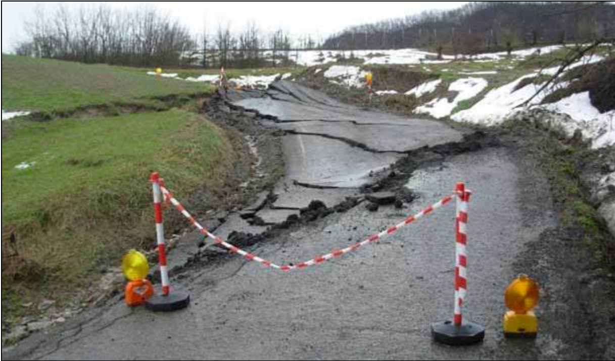
Fig. 24: frana di Casara. Cartografia e immagine della strada comunale coinvolta; si nota la ridotta estensione laterale del dissesto (fonte: www.sassuolo2000.it del 27 Febbraio 2015).
