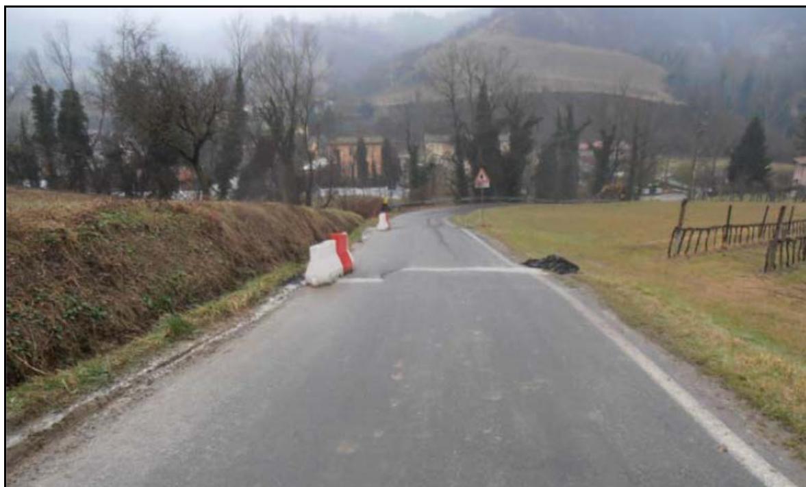
Fig. 22: frana di Zattaglia. Cartografia e immagine delle fratture lungo il corpo di frana e sulla strada provinciale (fonte: rapporto tecnico, Consorzio di Bonifica della Romagna occidentale).
