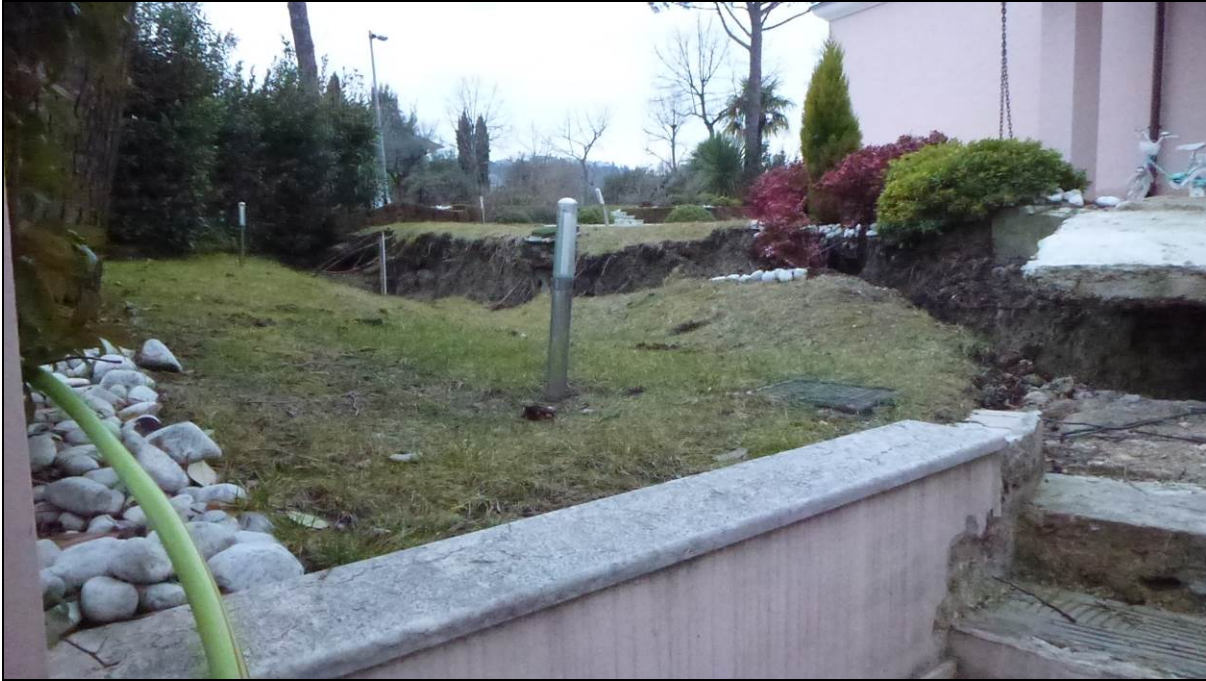
Fig 14: frana di Via Serra, Verucchio. Cartografia e immagini dei danni alla sede stradale coinvolta dalle fratture del coronamento (fonte: Frana a Verucchio in Via Serra, Facebook) e all'abitazione localizzata nella zona di coronamento (foto: Corrado Lucente, Servizio Area Romagna – Regione Emilia-Romagna).
