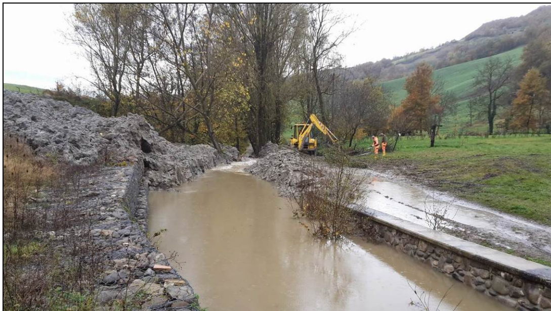
Fig. 8: porzione dell'accumulo che ha invaso temporaneamente il Torrente Tassobbio provocandone l'esondazione.
