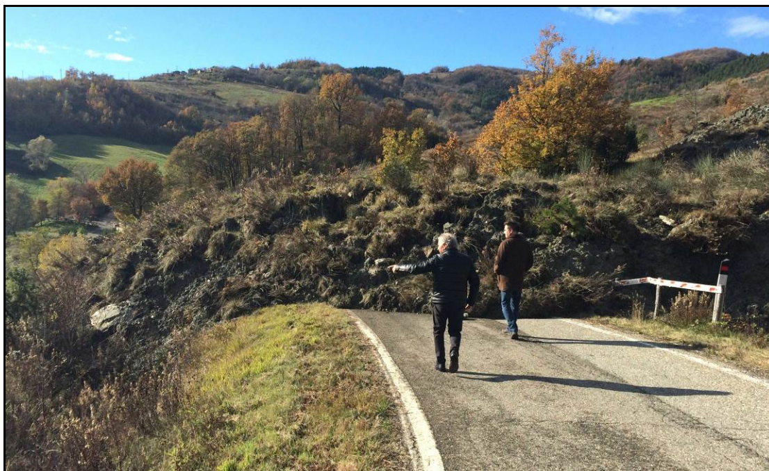
Fig. 9: frana di Bobbiano. Cartografia e foto della porzione di accumulo che ha invaso la SP 68. (fonte: www.liberta.it del 18 Novembre 2014)
