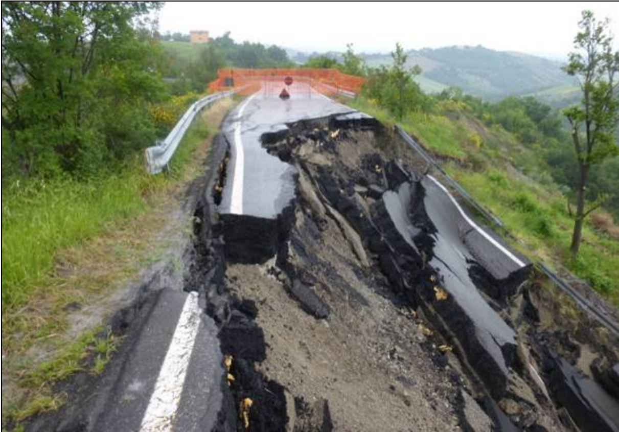
Fig. 42: frana di tipo c) in località Cresta del Gallo, Comune di Maranello (MO), avvenuta il 27 Marzo 2015, che ha interessato la SP 41. (fonte: Provincia di Modena).
