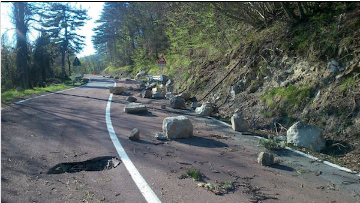
Fig. 43: frana di tipo b) in Comune di Vergato (BO), avvenuta il 29 Marzo 2015, che ha interessato la SP 25 al Km 5+200.
