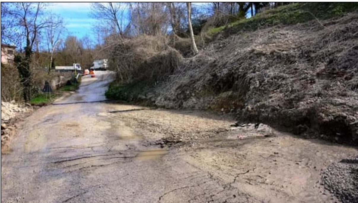
Fig. 33: frana di Soanne. Cartografia e particolare della strada provinciale interrotta (foto: www.riminitoday.it del 5 Maggio 2015)
