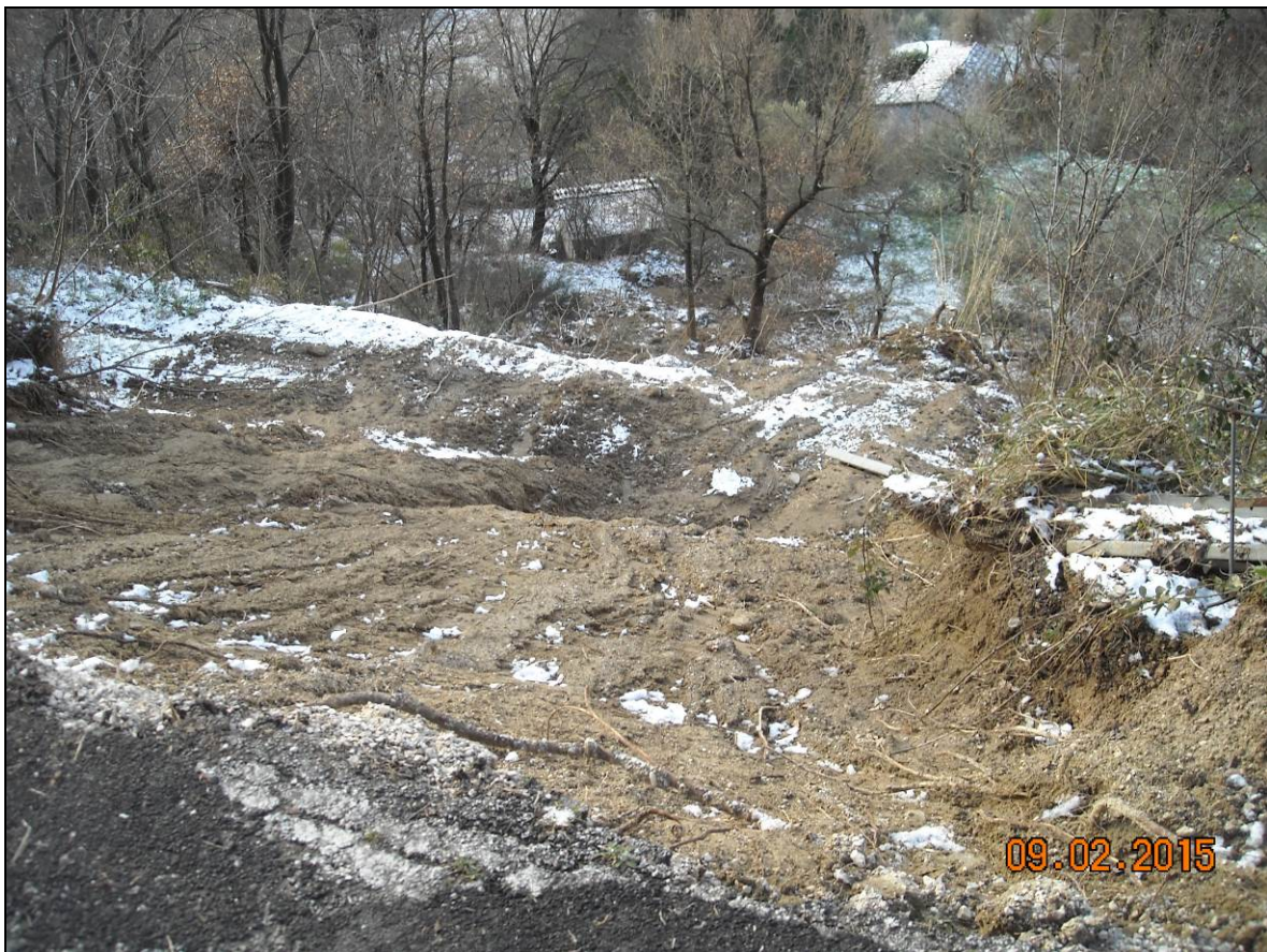
Fig. 37: frana di tipo c) in località Gaiano, Comune di Montescudo (RN), avvenuta il 7 Febbraio 2015, che ha interessato la SP 118 al Km 2+750. In alto: effetti sulla strada; in basso: estensione a valle del fenomeno. (fonte: Provincia di Rimini).
