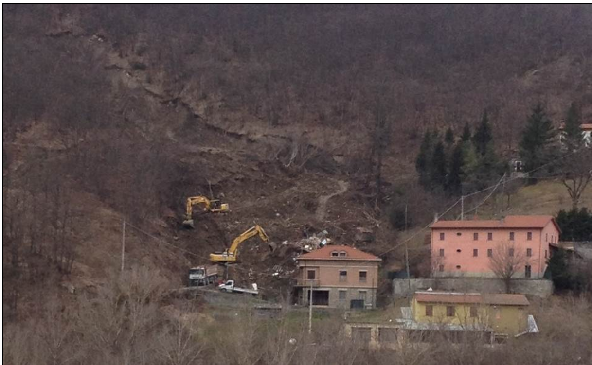
Fig. 28: frana di Case Mazzetti - Scorza. Cartografia e panoramica della frana (foto: Giovanni Truffelli, Servizio Area Affluenti del Po – Regione Emilia-Romagna).
