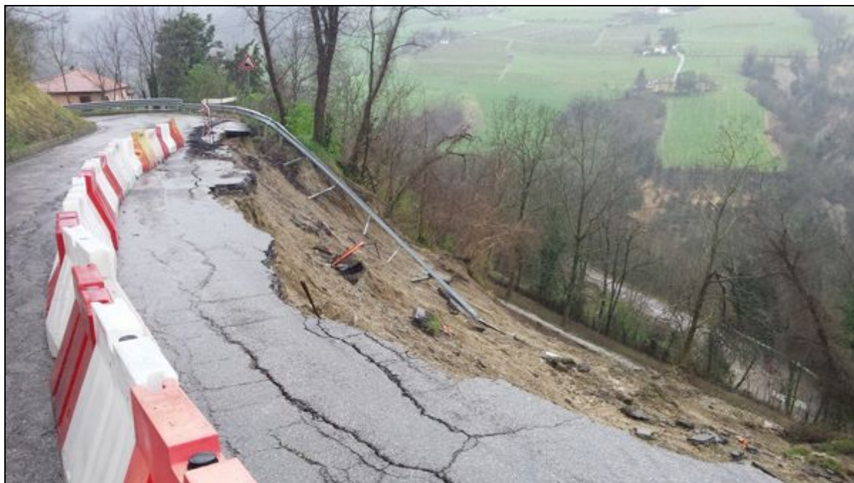
Fig. 36: frana di tipo c) in località bivio Marsignano, Comune di Predappio (FC), avvenuta il 7 Febbraio 2015, che ha interessato la SP 54.(fonte: Provincia di Forlì Cesena).
