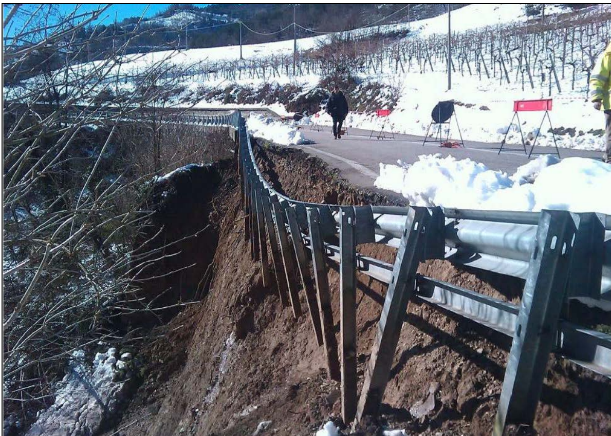
Fig. 35: frana di tipo c) in Comune di Tredozio (FC), avvenuta il 7 Febbraio 2015, che ha interessato la SP 20 al Km 11+200. (fonte: Provincia di Forlì Cesena).
