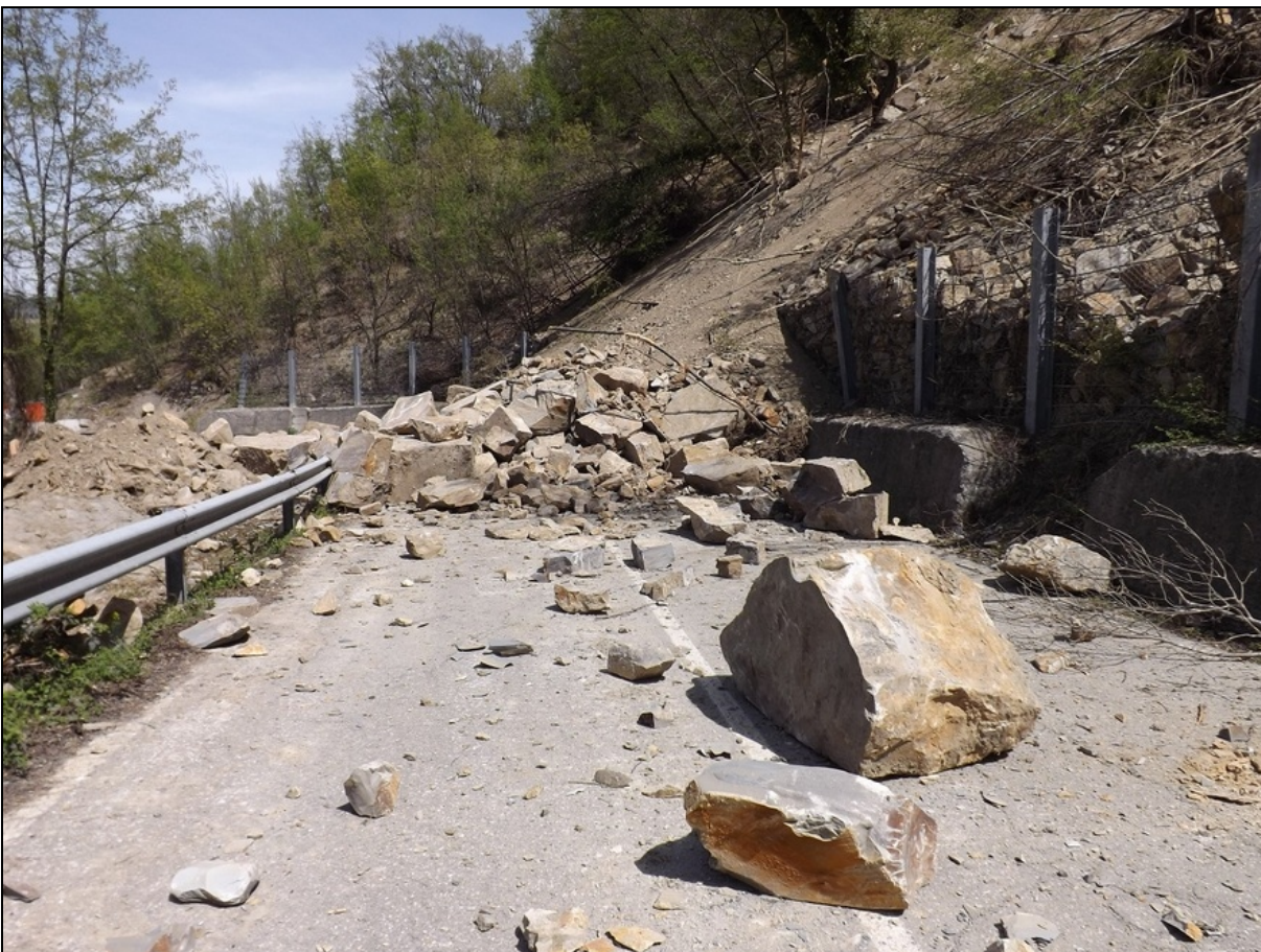
Fig. 45: frana di tipo b) in Comune di Montese (BO), avvenuta il 9 Aprile, che ha interessato la SP 27. (fonte: http://gazzettadimodena.gelocal.it/ , foto: Daniele Montanari ).
