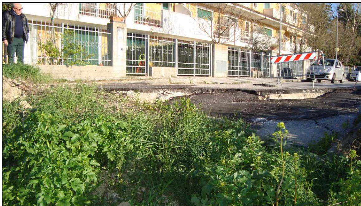
Fig. 31: frana di Via Pieve. Cartografia e particolare della scarpata di frana (fonte: Dossier frane Valconca dei comuni dell'Unione della Val Conca - http://www.comune.gemmano.rn.it/news/dossier-frane-valconca-eventi-2015/ )
