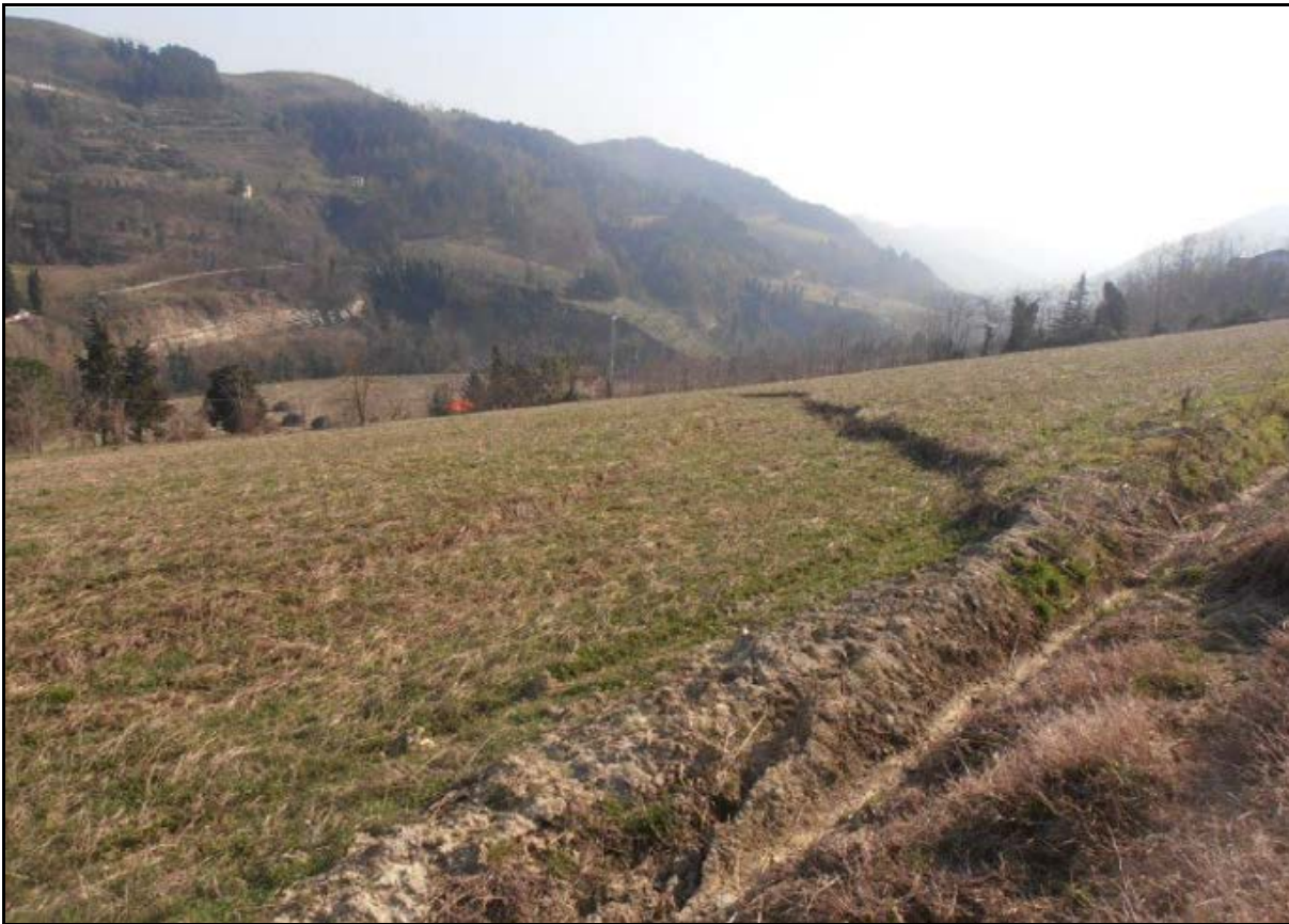
Fig. 21: frana di Vico. Cartografia e particolare della zona di distacco (foto: Gabriele Minardi, Consorzio di Bonifica della Romagna occidentale).
