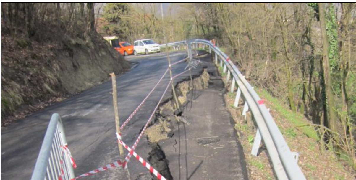
Fig. 41: frana di tipo c) in località Borsea, Comune di San Polo (RE), avvenuta il 27 Marzo 2015, che ha interessato la SP 73. (fonte: Provincia di Reggio Emilia).
