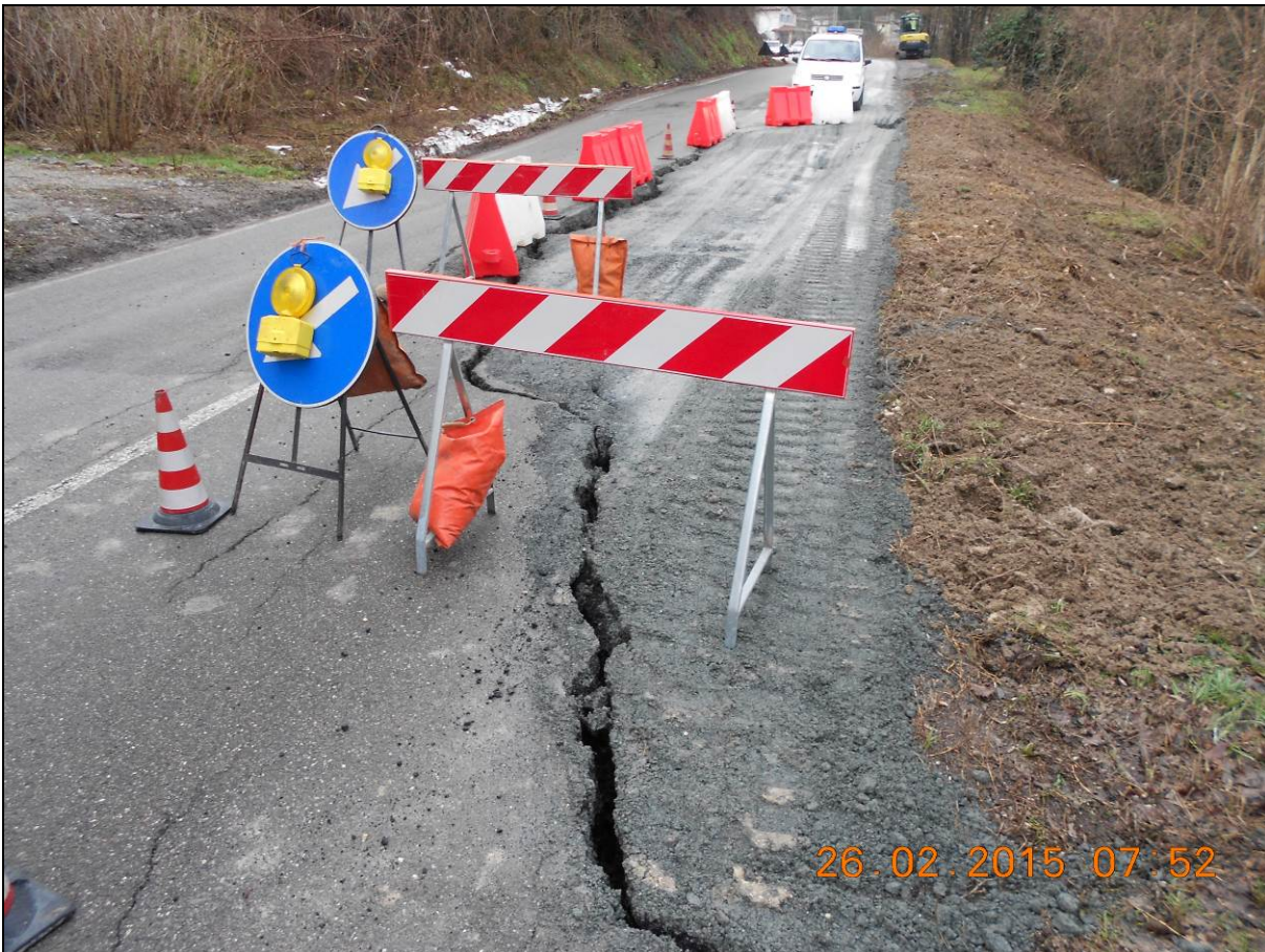
Fig. 38: frana di tipo c) in località Pioppone, Comune di Calestano (PR), avvenuta il 25 Febbraio 2015, che ha interessato la SP 15. (fonte: Provincia di Parma).
