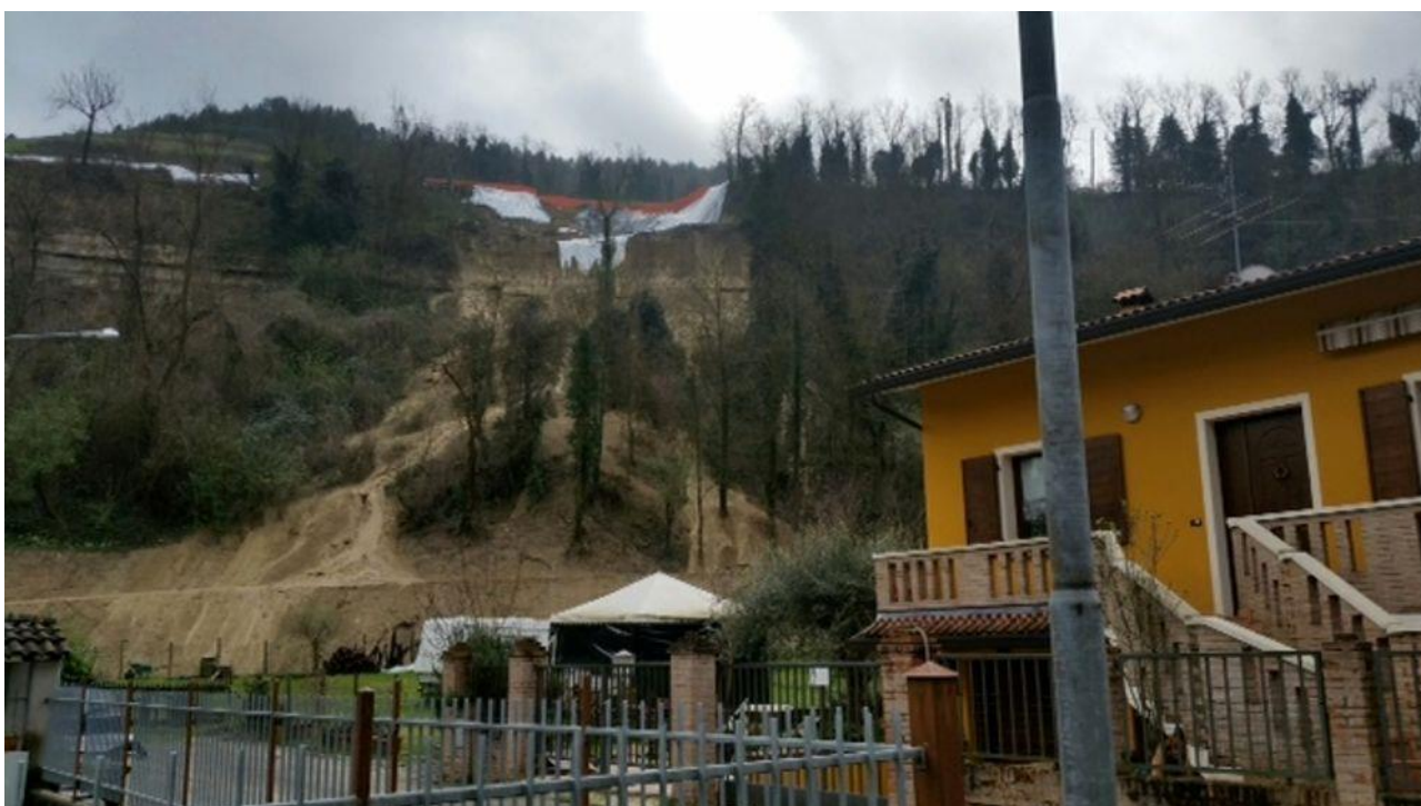
Fig. 14 - Immagine della frana di Trove (Dovadola, FC) vista dal basso (da www.forlitolitoday.it del 08/03/2016). In primo piano i depositi di colata provenienti dalla pendice. In secondo piano la strada e i teloni provvisori posti a protezione dalle infiltrazioni nella area di coronamento. Si notano anche le recinzioni provvisorie rosse che erano in loco già prima della riattivazione in oggetto, che delimitavano l'area già franata nel 2015.
