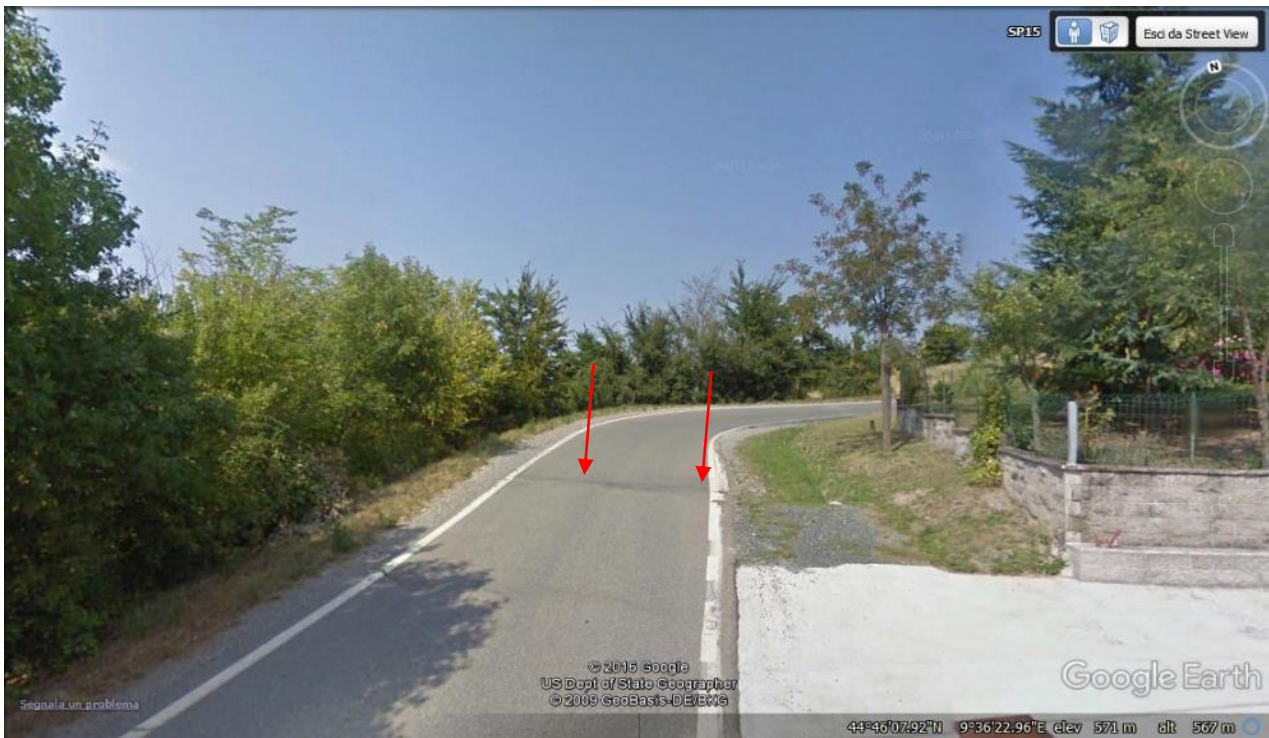
Fig. 12 - Stato della strada Provinciale nei pressi di Pergalla (PC) nell'Agosto 2011. Si nota una frattura nello stesso tratto visibile nell'immagine in basso a destra della figura 11. Immagine scaricata da Google Earth – Streetview.
