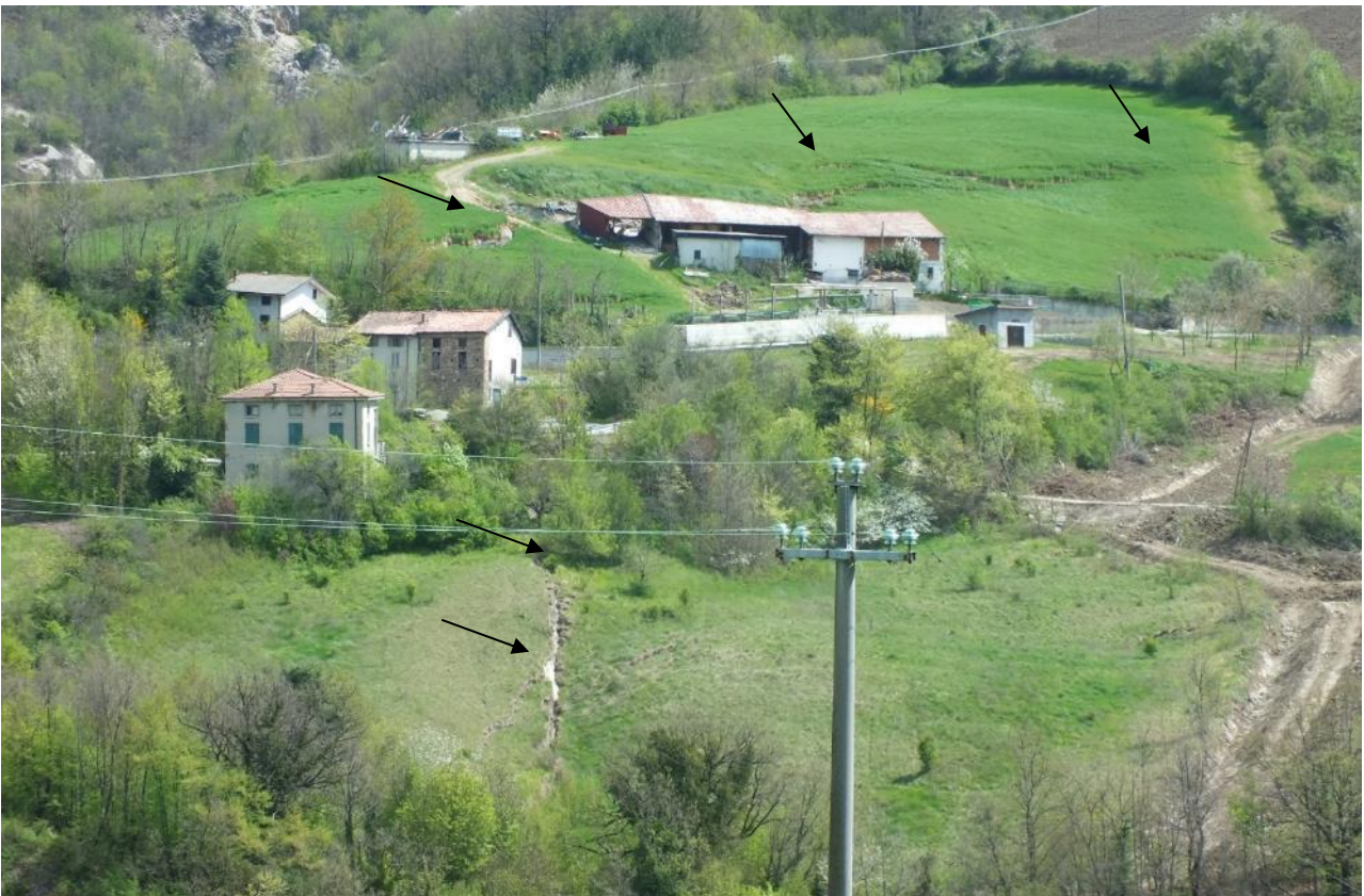
Fig. 10 - Particolare del fianco Nord della frana di Pergalla (Bettola, PC). Le frecce indicano il limite del movimento.
