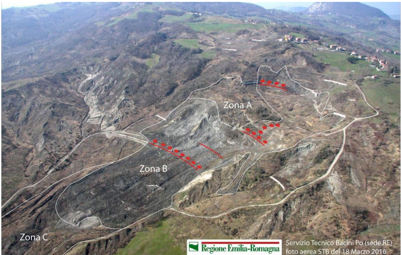
Fig. 19 - Parte medio alta della porzione riattivata della frana di Cà Lita (Baiso, RE). Foto e interpretazione di Giovanni Bertolini del Servizio Area Po – Regione Emilia-Romagna. Zona A: Area soggetta a scorrimento profondo; zona B: colata di neoformazione; zona C: riattivazione di accumulo preesistente per carico da monte.
