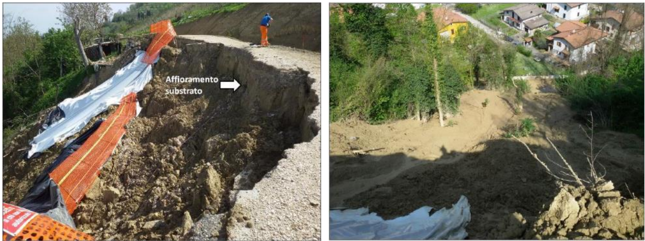
Fig. 15 - Immagini della frana di Trove (Dovadola, FC). Immagini tratte dalla Relazione (inedita) di sopralluogo prodotta dal Prof. Berti - Università degli studi di Bologna, dipartimento BiGeA, per la Agenzia Regionale per la sicurezza territoriale e la Protezione Civile. A sinistra particolare della nicchia di coronamento in corrispondenza della strada comunale di monte, già stata interessata dall'evento del 2015 e aveva subito interventi di ripristino non risolutivi. A destra scarpata interessata dalla fluidificazione del materiale e dal suo colamento fino in prossimità delle abitazioni sottostanti.
