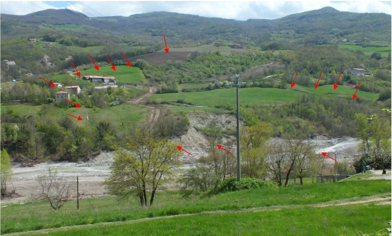
Fig. 9 - Panoramica della frana di Pergalla (Bettola, PC). Le frecce indicano le tracce visibili del limite della frana.
