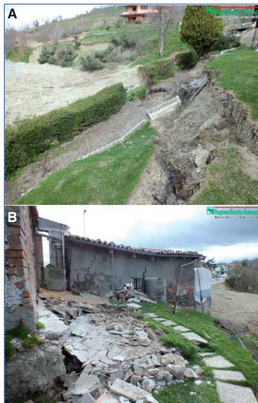
Figura 16. Danni nei pressi del coronamento della frana di Rontagnano (Sogliano al Rubicone, FC) (foto del SGSS).
