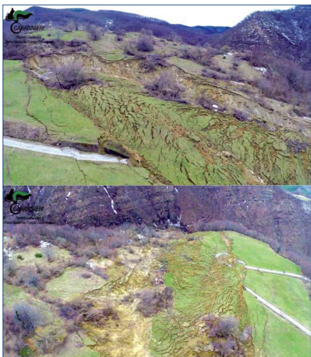
Figura 17. Particolari della frana di Pian di Stura (Portico e San Benedetto, FC): in alto vista del coronamento, in basso vista del piede della frana. Nella foto in basso, a destra, si nota la strada forestale distrutta dal movimento e dislocata di circa 15 metri a valle (foto dei Carabinieri Forestali del Parco Nazionale Foreste Casentinesi).
