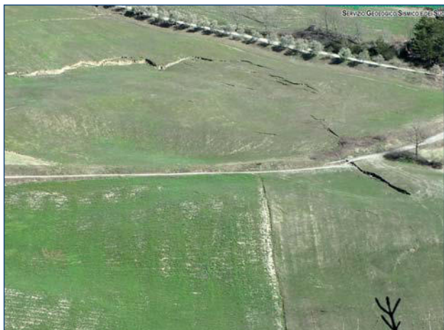
Figura 13. Scivolamento in terra in loc. Fondi (Portico e San Benedetto, FC); lo spostamento a carico della strada interessata dalla frana è di circa 2 m (foto del SGSS).
