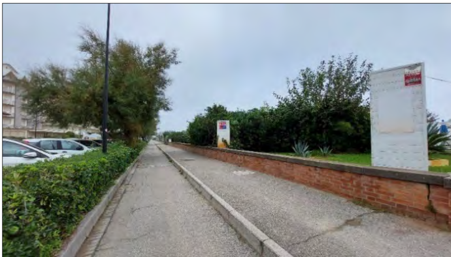
Figura 79: L'area n.15 è caratterizzata da muretti di circa 50cm lato strada e protezioni con dune/onduline a mare.
