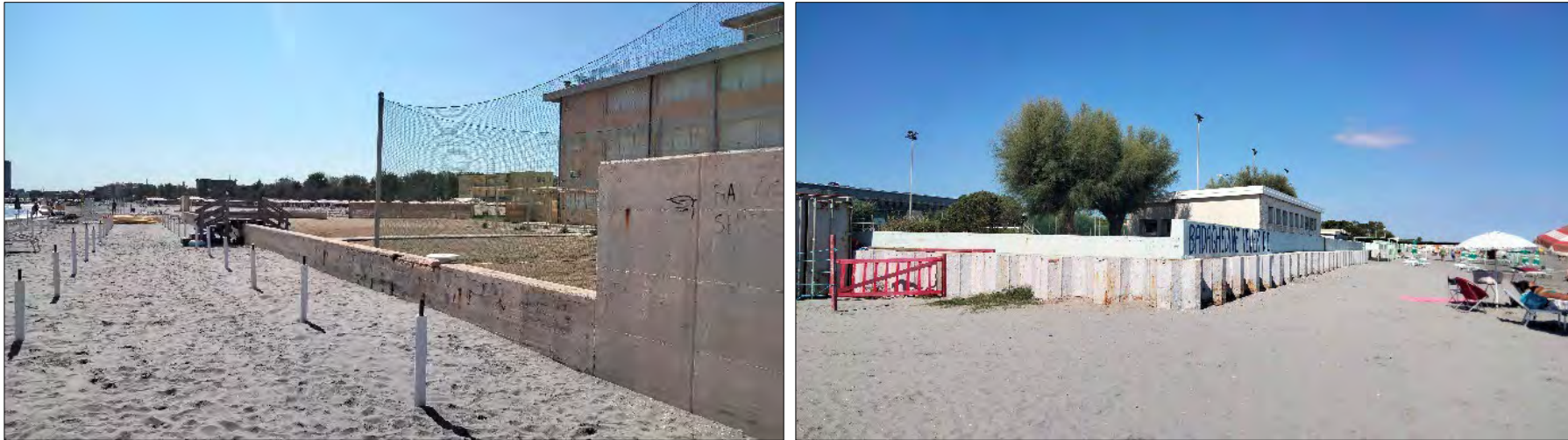
Figura 91: dettagli delle protezioni individuate in area 4, costituite da tipologie eterogenee e con quote non sempre utili a contrastare l'ingressione marina.
