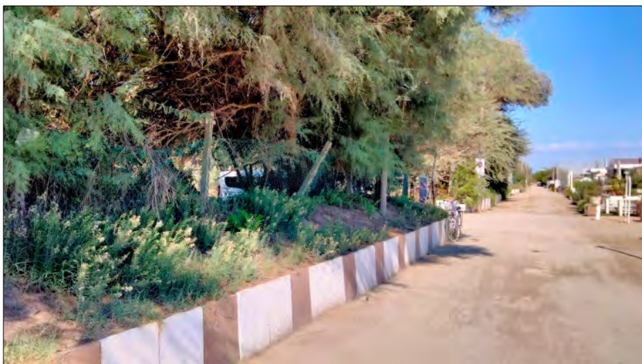
Figura 88: tipologia di muretto lungo l'arenile demaniale in prossimità del varco 2
