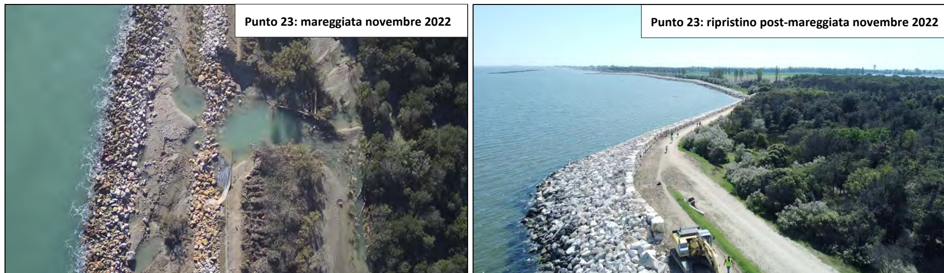
Figura 22: situazione al punto 23 a seguito della mareggiata del novembre 2022 e panoramica dopo il ripristino.
