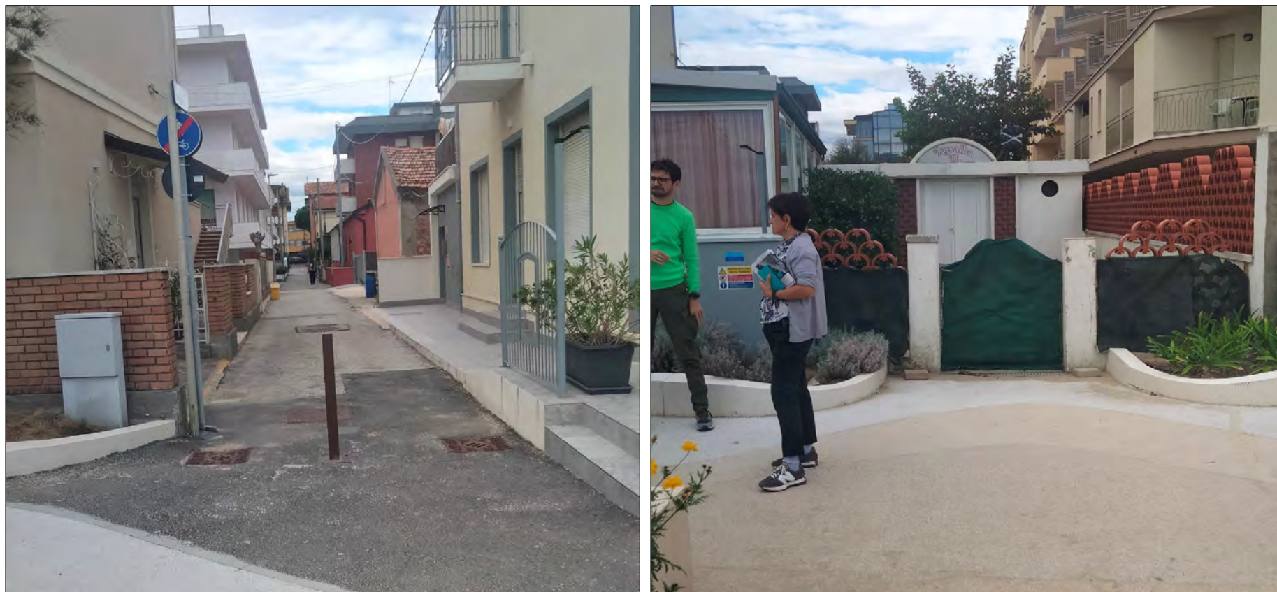
Figura 112: dettagli criticità presenti in area 7, con il piano di calpestio che dal lungomare tende ad abbassarsi verso l'entroterra
