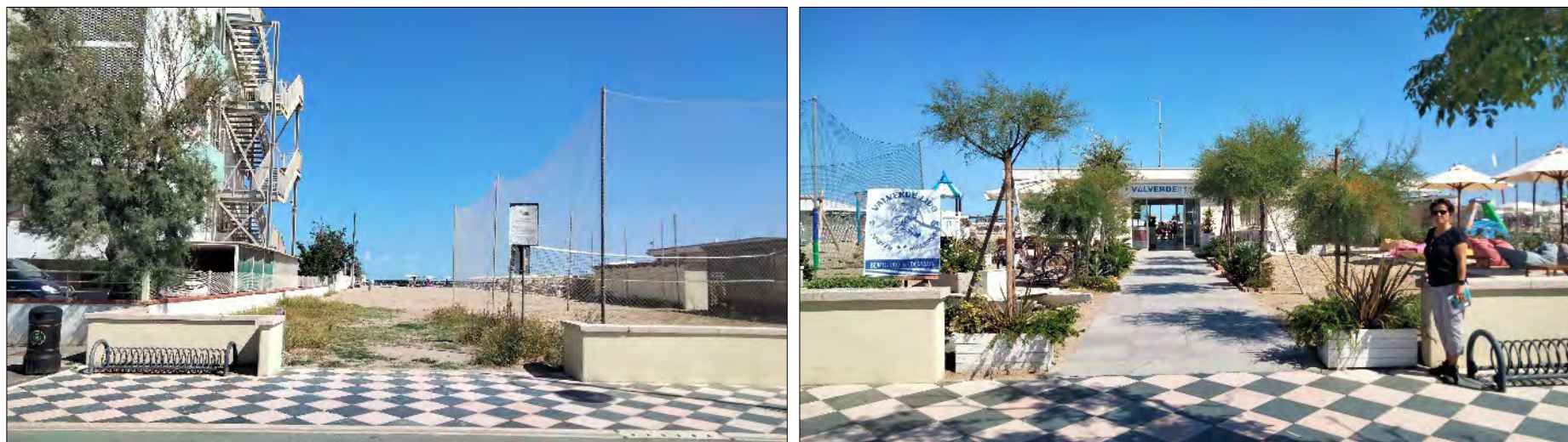
Figura 98: situazione lungo V.le Carducci (area 10) dove i muretti risultano bassi, con varchi ampi e non idoneamente predisposti a chiusura in caso di mareggiata.
