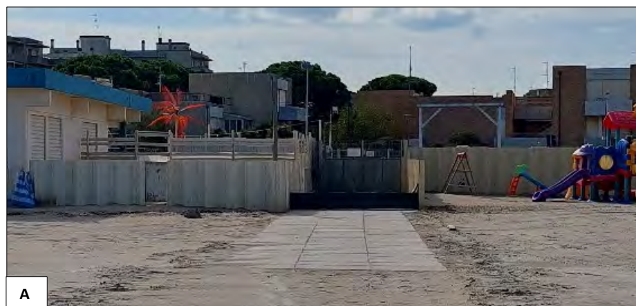
Figura 54: A proseguire verso S (aree 38-39-40) le protezioni risultano piuttosto eterogenee, con muretti di circa 90 cm lato strada (presente solo fino a bagno Sabbia d'Oro) ma anche palancole di varie altezze attorno al parco giochi/pista kart. In questa zona è presente un accesso correttamente protetto (A). In figura B è possibile notare la vicinanza dei condomini alla linea di riva (circa 40-50 m).
