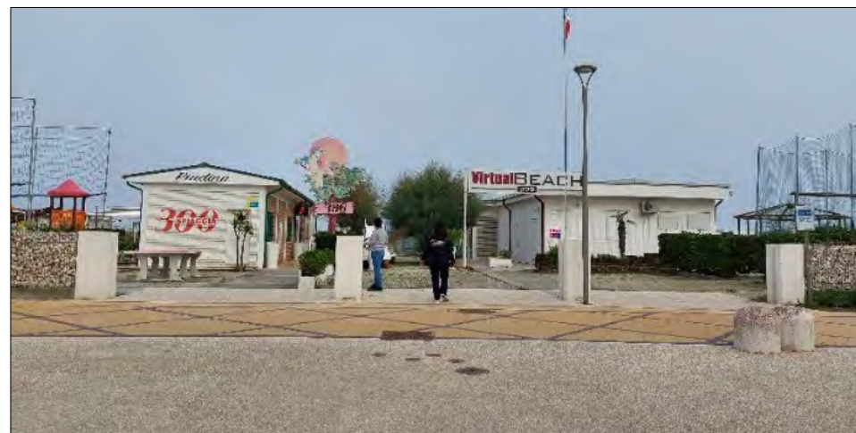
Figura 69: in queste immagini vengono evidenziate alcune criticità individuate nel nuovo lungomare di Milano Marittima: in generale, al posto di veri e propri muretti sono stati installati gabbionate di pietrisco, che risultano quindi non avere adeguate caratteristiche di impermeabilità. Sono inoltre numerosi gli accessi/varchi senza protezione, come riportato in queste immagini relative al tratto 5. Particolarmente ampio è il varco in posizione frontale i bagni 299-300.
