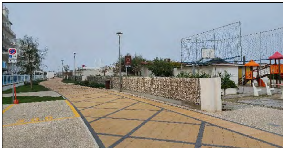
Figura 69: in queste immagini vengono evidenziate alcune criticità individuate nel nuovo lungomare di Milano Marittima: in generale, al posto di veri e propri muretti sono stati installati gabbionate di pietrisco, che risultano quindi non avere adeguate caratteristiche di impermeabilità. Sono inoltre numerosi gli accessi/varchi senza protezione, come riportato in queste immagini relative al tratto 5. Particolarmente ampio è il varco in posizione frontale i bagni 299-300.
