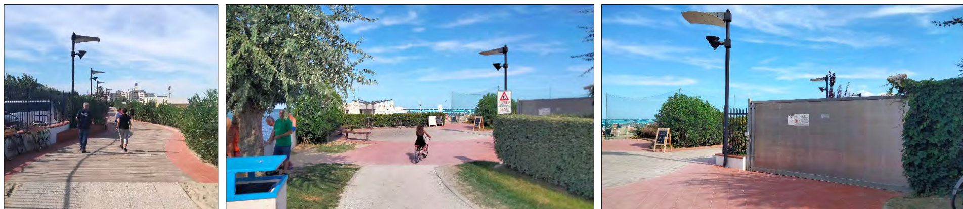
Figura 101: Panoramica situazione nell'area attualmente occupata dal campeggio camping Rubicone (area 14), dove sono stati realizzati camminamenti, muretti e cancellate che sembrano idonee a contenere eventuali allagamenti da mareggiata.
