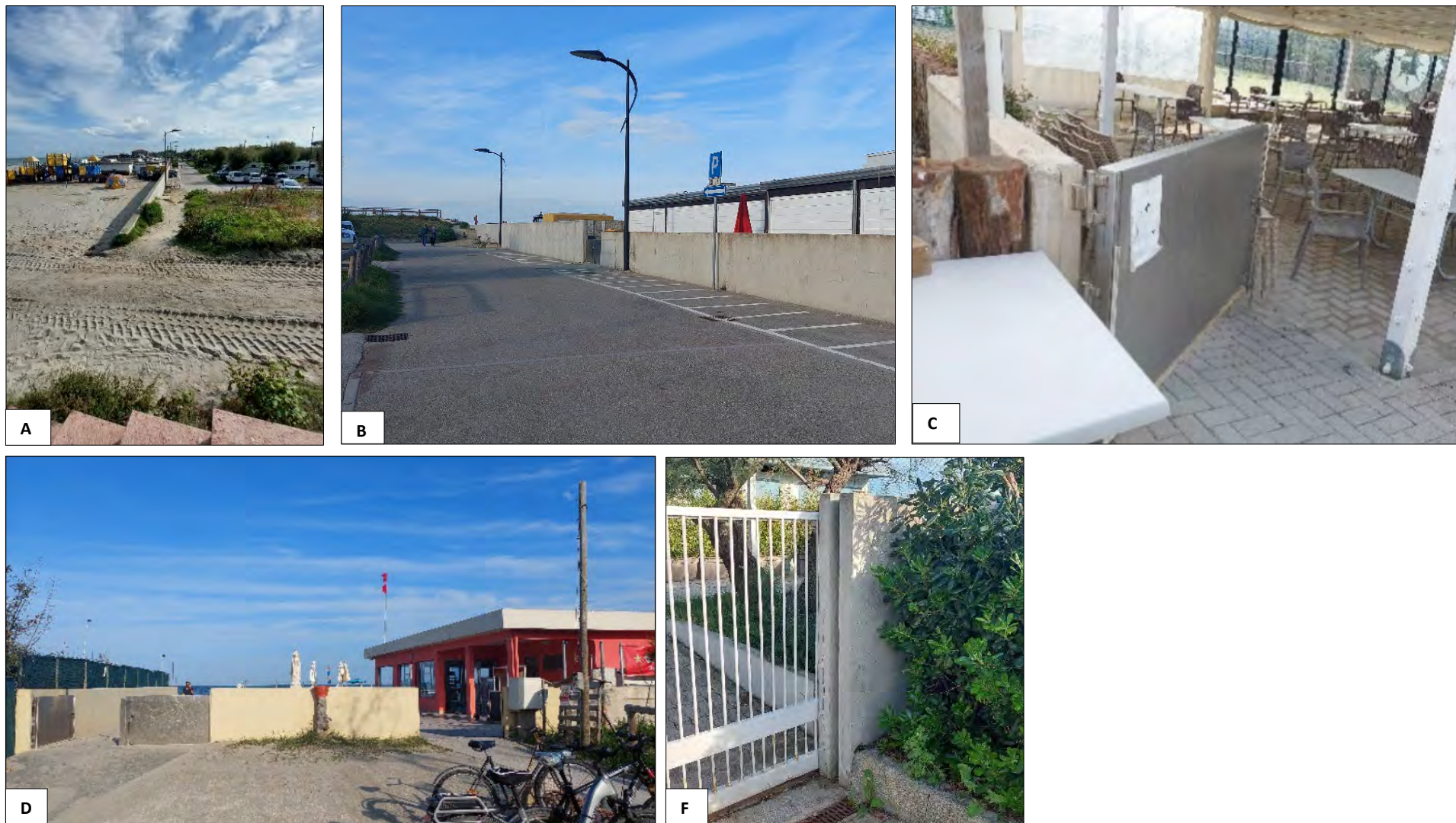
Figura 57: Panoramica area 43. Nelle immagini A e B è visibile il muretto realizzato partendo dalla zona del primo pennello, si segnala la necessità di rilevare la quota del varco tra il pennello e la testa del muretto. Il muretto in questione a volte è fatto passare frontalmente o all'interno degli stabilimenti (C) altre volte a retro (D). Ogni stabilimento presenta un accesso principale con cancellata e scassi nel muretto per accogliere le paratie: come dichiarato dagli stessi gestori, però, queste non vengono poi effettivamente installate in caso di mareggiata (F).
