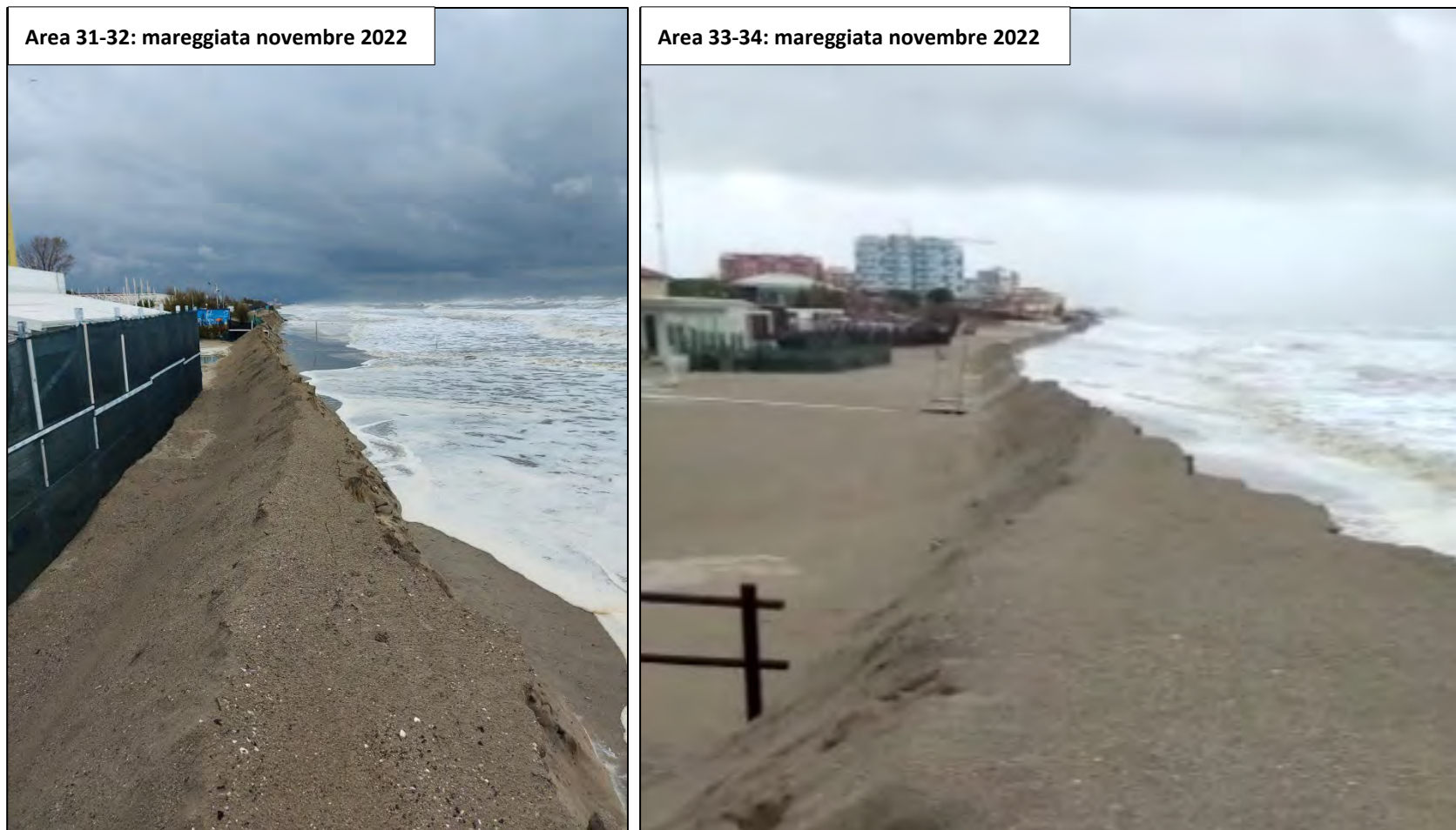
Figura 28: dettagli erosione dune invernale in occasione di mareggiata a Lido di Pomposa e Scacchi.
