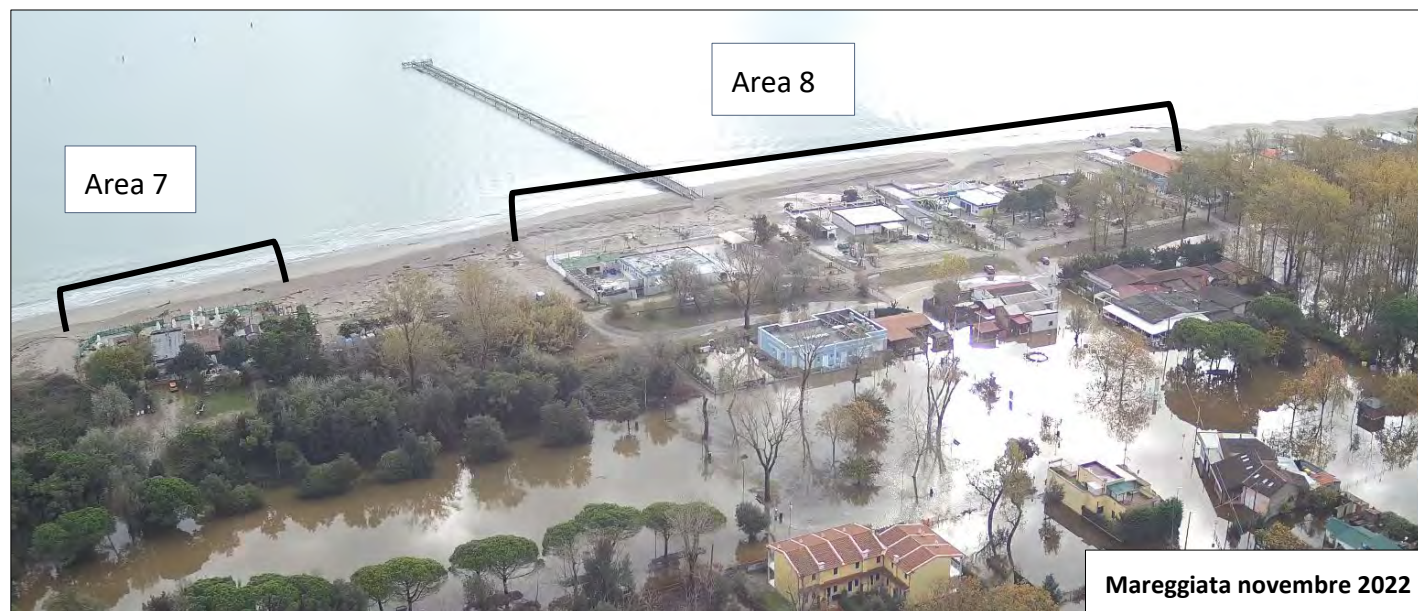
Figura 16: dettagli criticità dei punti 5-6-7-8.
