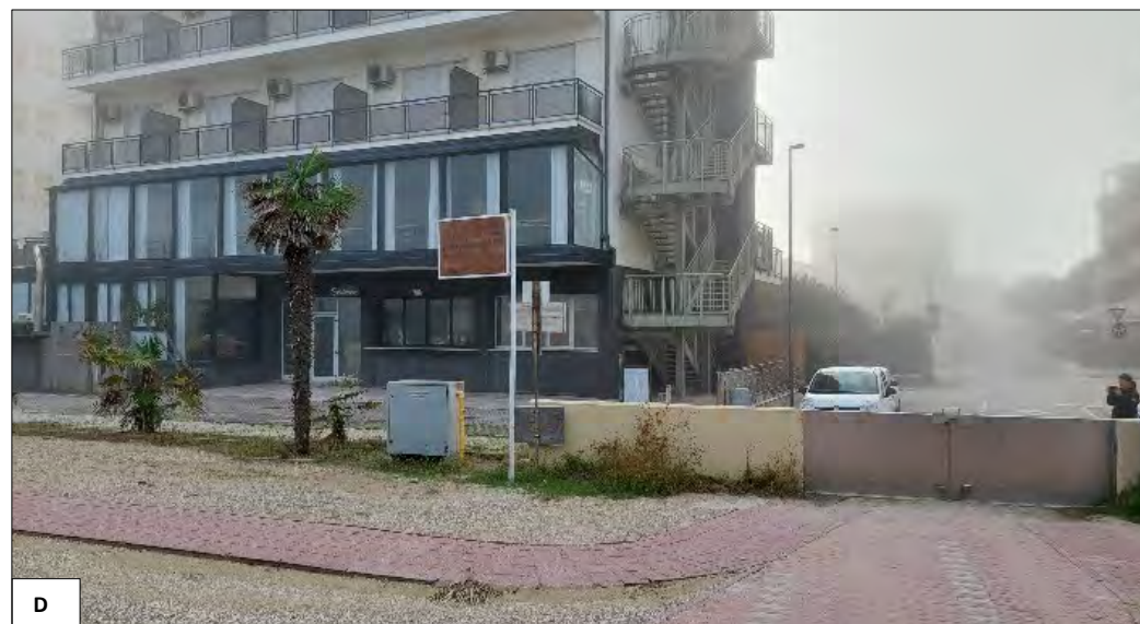
Figura 62: panoramica area 48. Anche a Lido di Savio si è proceduto alla realizzazione di muretti e accessi tramite cancelli a paratia (A), vanno tuttavia attentate alcune specifiche casistiche, come muretti non idoneamente interconnessi (C-D) o aree sfornite di apposite paratie ai varchi (B).
