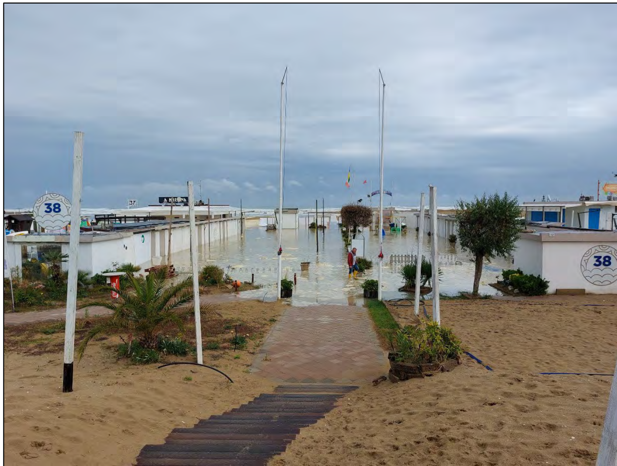
Figura 127: allagamento in occasione di una mareggiata nel tratto dell'area 26
