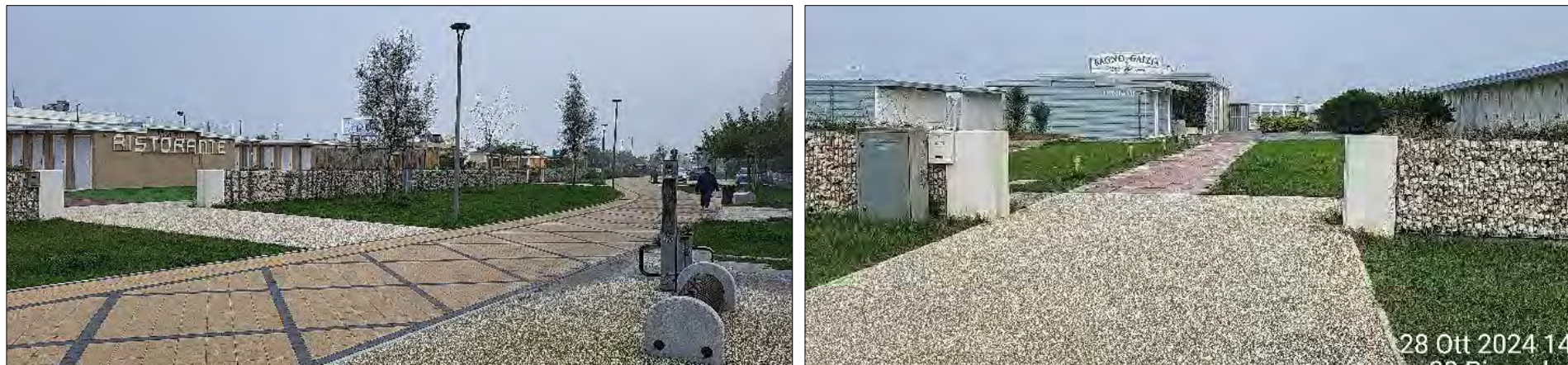
Figura 70: stesse problematiche del punto precedente sono riscontrate all'area 6.
