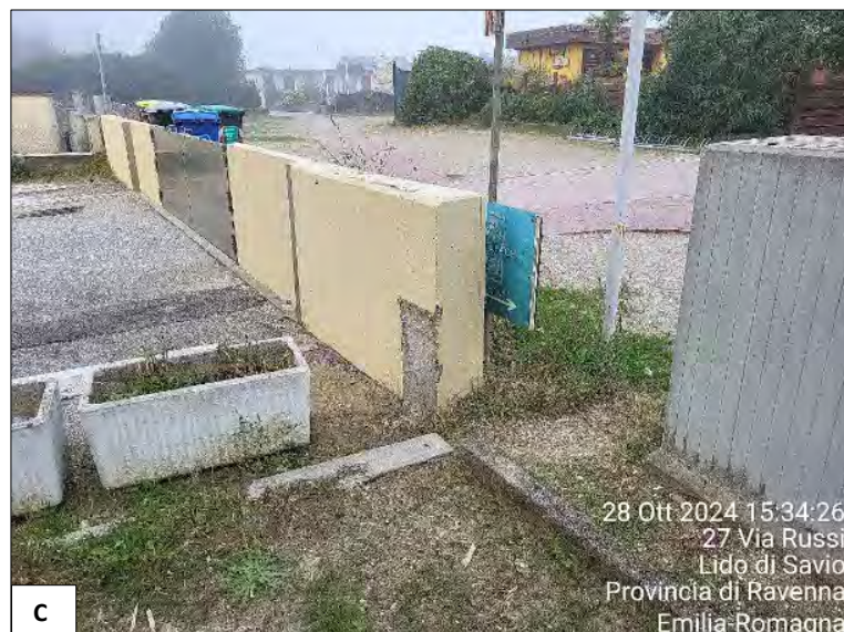
Figura 62: panoramica area 48. Anche a Lido di Savio si è proceduto alla realizzazione di muretti e accessi tramite cancelli a paratia (A), vanno tuttavia attentate alcune specifiche casistiche, come muretti non idoneamente interconnessi (C-D) o aree sfornite di apposite paratie ai varchi (B).
