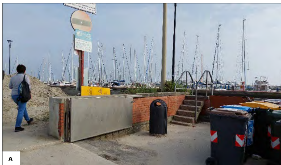
Figura 75: durante il sopralluogo è stato riscontrato che, per compensare la mancata tenuta dei gabbioni, sono stati installati pannelli in plexiglass in posizione retrostante il camminamento su buona parte del waterfront, come ad esempio in area 11.
