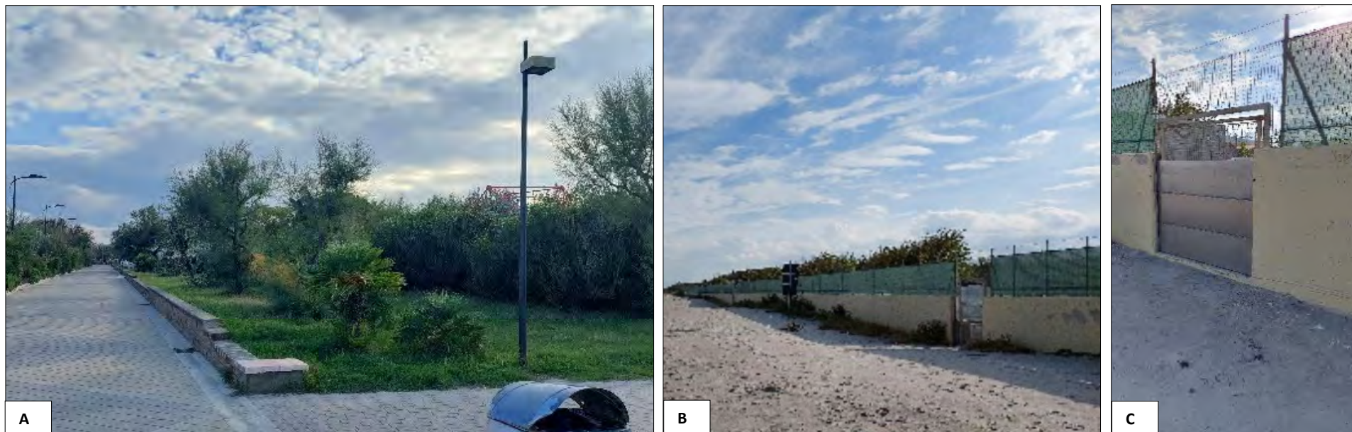
Figura 58: Lungo V.le Matelda, alle spalle degli stabilimenti il nuovo waterfront è realizzato con vegetazione posiziona a una quota maggiore (A), tale da costituire un dosso contro l'ingressione marina verso i caseggiati retrostanti. A proseguire verso sud fino alla pineta un muro idoneamente presidiato corre lungo l'area campeggi (B-C).
