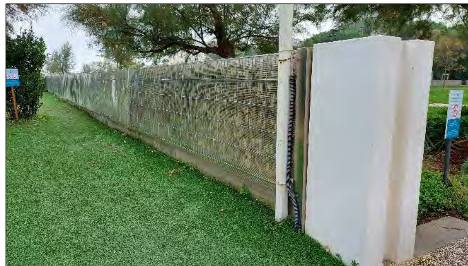
Figura 75: durante il sopralluogo è stato riscontrato che, per compensare la mancata tenuta dei gabbioni, sono stati installati pannelli in plexiglass in posizione retrostante il camminamento su buona parte del waterfront, come ad esempio in area 11.
