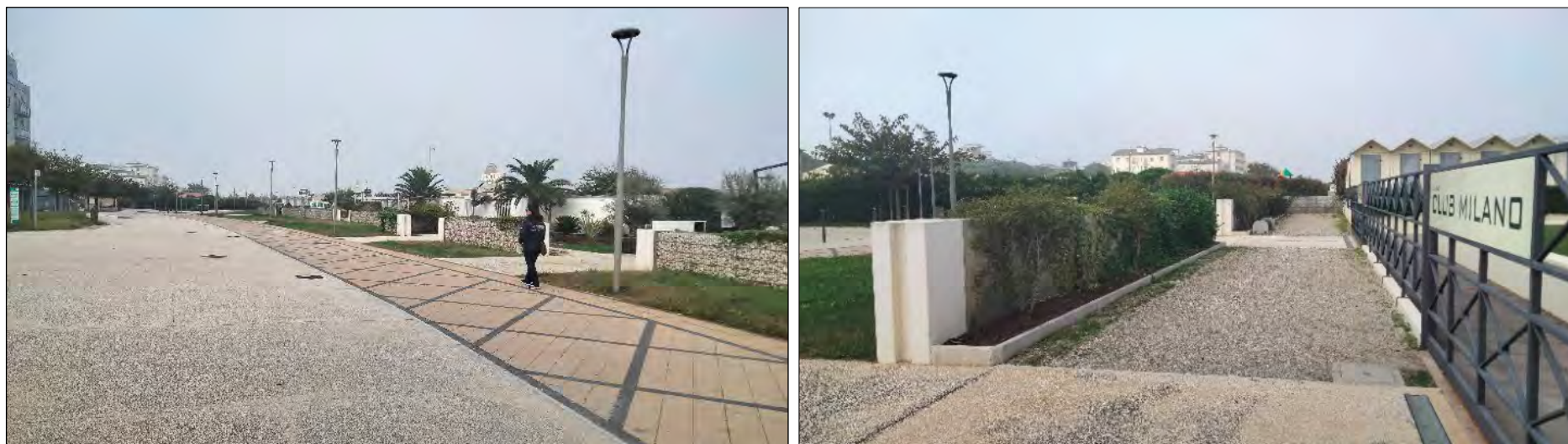
Figura 71: Per il tratto n.7 sono stati individuati nuovamente molteplici accessi/varchi senza protezione e muretti non impermeabili.
