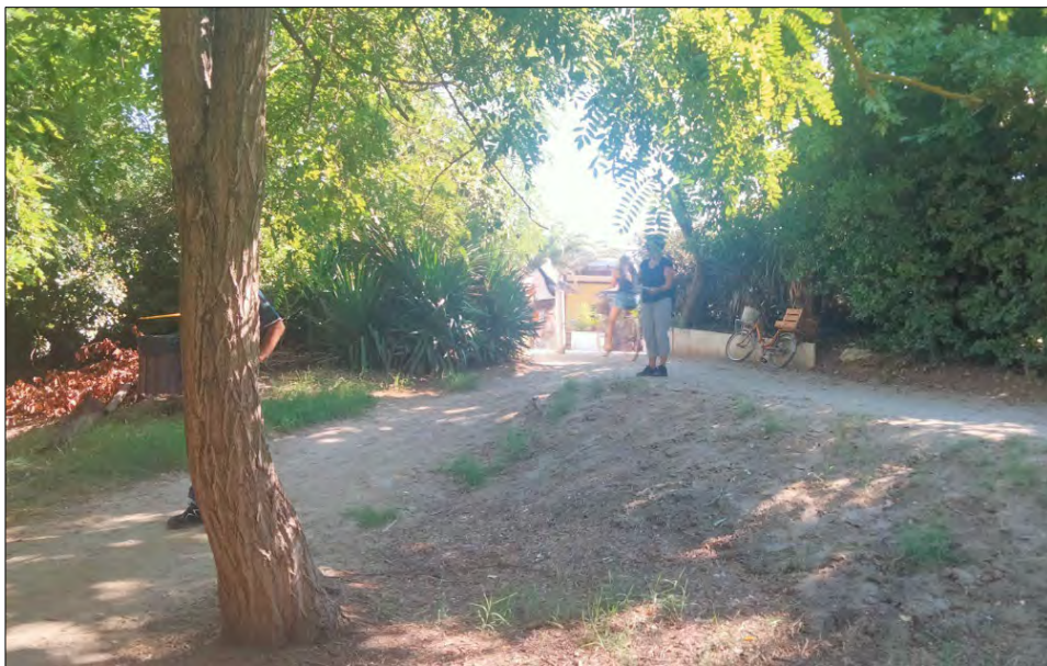
Figura 89: Veduta varco 3 dove manca un'ideale predisposizione alla chiusura in caso di allagamento da mareggiate e dove le pendenze non impediscono l'ingresso nell'entroterra, in questo caso costituita dalla pineta.
