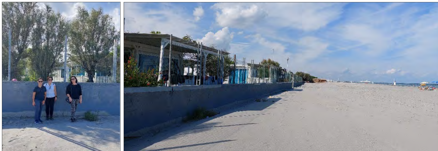
Figura 51: muro perimetrale il campeggio Pini Beach Village in area 35.
