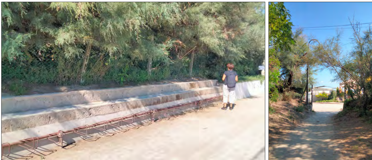
Figura 87: dettaglio tipologia di muretto lungo l'arenile demaniale in prossimità del varco 1 e veduta varco n.1 dove manca un'ideale predisposizione alla chiusura in caso di allagamento da mareggiate e dove le pendenze non impediscono l'ingresso nell'entroterra, in questo caso costituita dalla pineta.
