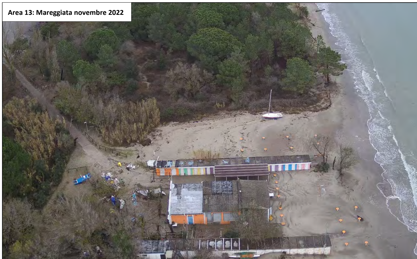
Figura 18: tracce di ingressione marina nell'area 13 a seguito della mareggiata del novembre 2022.
