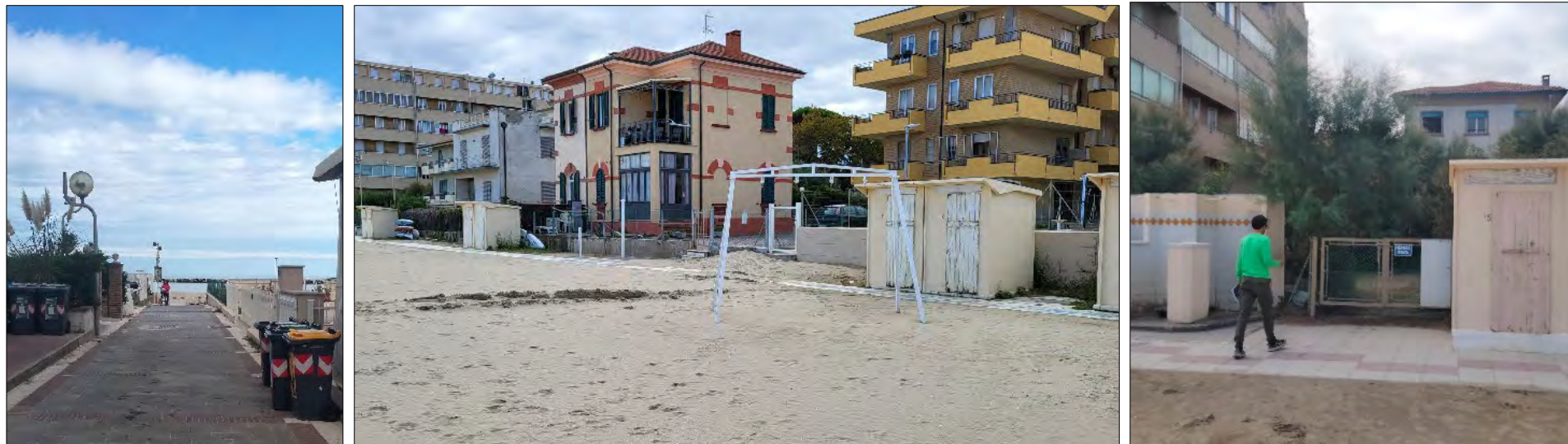
Figura 123: dettagli area di varco n. 19 dove sono presenti muretti piuttosto eterogenei per altezza e tipologia, e accessi alle abitazioni/alberghi con cancelli che non consentono idonea protezione in caso di ingressione marina.
