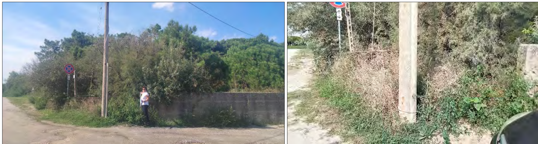
Figura 50: dettaglio tratto terminale del muro di protezione che costituisce possibile varco punto 34.
