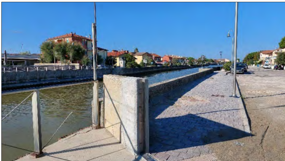
Figura 38: Punto 9 varco con predisposizione a chiusura presso canale portuale
