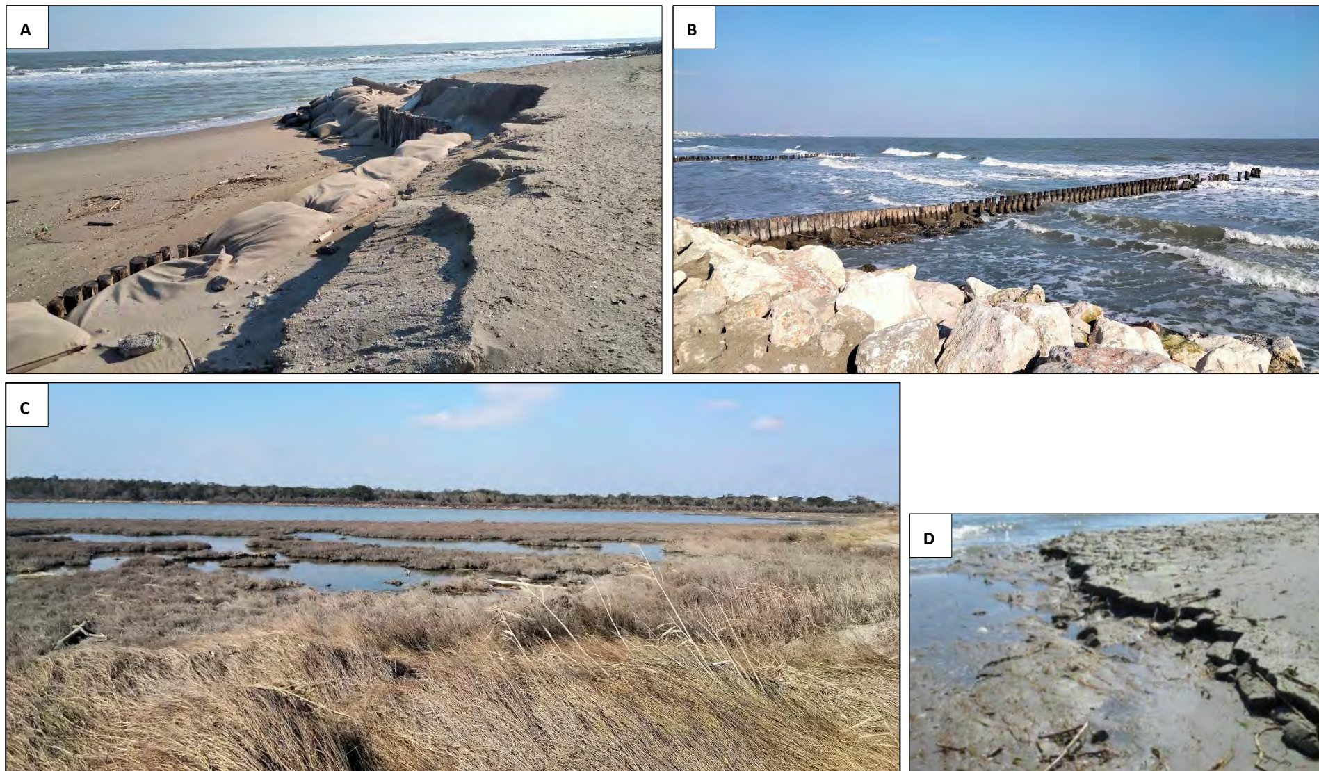
Figura 32: veduta del territorio della Sacca di Bellocchio. A-B erosione de litorale e danneggiamento opere di difesa; C area lagunare retrostante il cordone litorale. In alcuni punti, a causa del progressivo arretramento della spiaggia, vengono a giorno le argille proprie del sistema lagunare (D).
