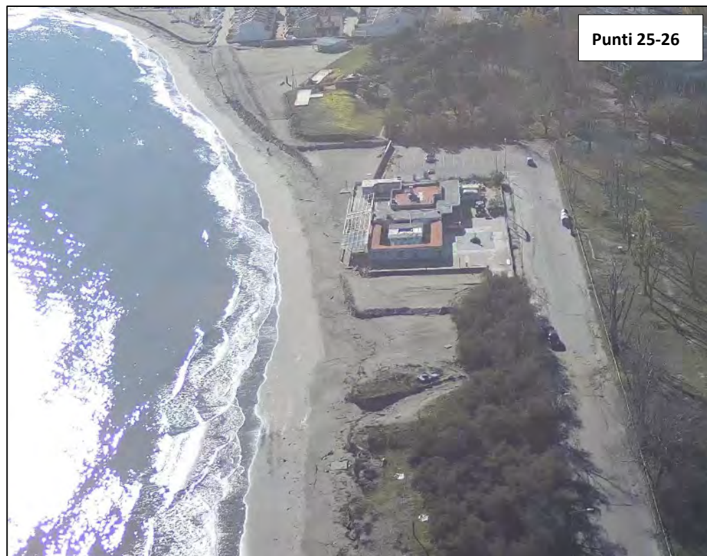
Figura 24: tracce di ingressione marina ai punti 25-26 a seguito della mareggiata del novembre 2022.
