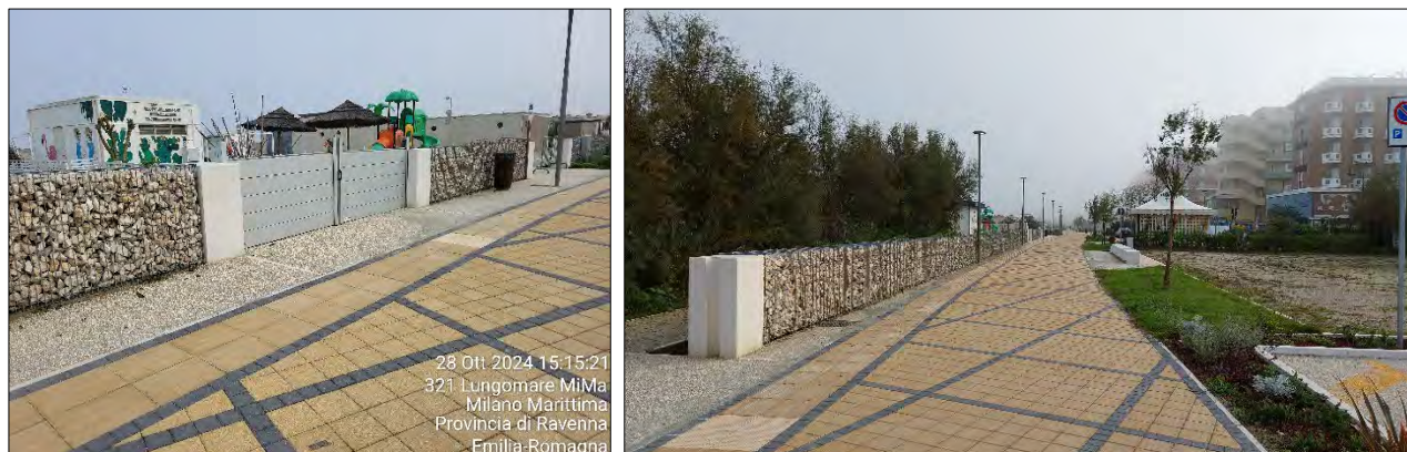
Figura 67: tratto area 4 dove era stata installata una sola chiusura agli accessi ai bagni
