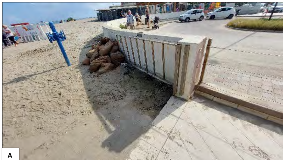
Figura 53: (A) dettaglio rotonda di V.le Virgilio in area 37. Sono presenti cancellate non idonee a contenere l'ingresso marina, come quella in foto, o varchi tra i muretti con scassi per paratie che non vengono però installate viste le recenti tracce di allagamenti e trasporto sabbia in strada. (B) particolare dello stradello area 38 che collega V.le Petrarca alla spiaggia, che al momento del sopralluogo era stato protetto con sacchettature vista la mareggiata di qualche giorno prima. È possibile notare come il muretto sulla destra dello stradello (N) abbia un'altezza idonea, mentre quelli sulla sinistra (S) presentano un'altezza del tutto insufficiente e cancelli che possono costituire ulteriori punti di ingresso.
