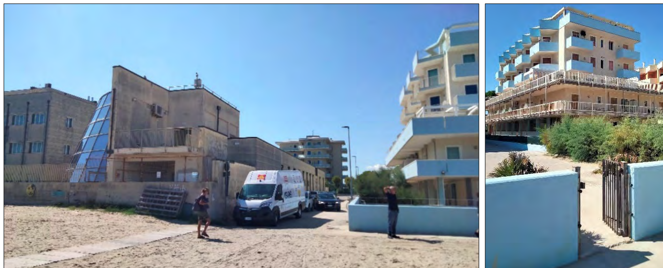
Figura 97: dettaglio via Quasimodo in area 10. Per quanto sembrano recenti gli interventi di manutenzione degli scassi per l'inserimento delle paratie si denotano fessurazione probabilmente causate dall'impatto con mezzi da lavoro, si raccomandano quindi periodiche verifiche.
