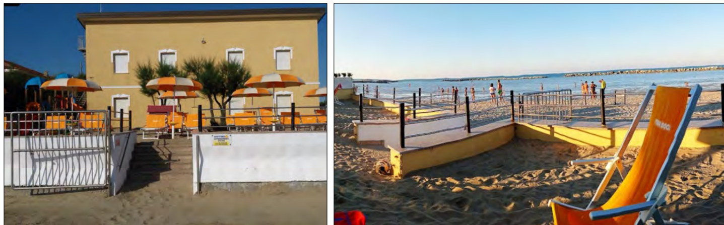
Figura 103: dettaglio caseggiato in area 16, ubicato a pochi metri dalla linea di costa e posizionato ad una quota sopraelevata di circa 120 cm dalla quota spiaggia.
