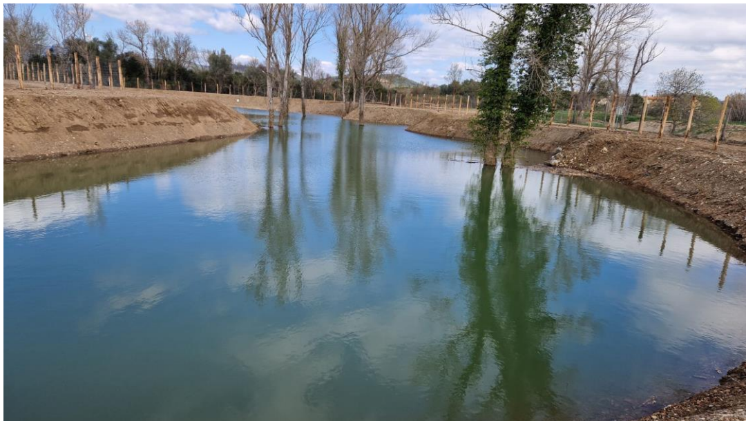
In figura: Impianto di ricarica della falda in condizioni controllate LIFE REWAT (Suvereto).
