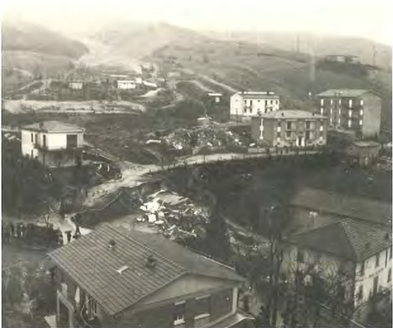
FIG. 3 - La frana di Ciano "entra" nel centro abitato (vista dal campanile della vicina chiesa). E' l'11 marzo del 1972. Un paio di edifici sono già crollati, mentre il teatro, in secondo piano a destra, è ancora intatto; verrà lesionato successivamente.
