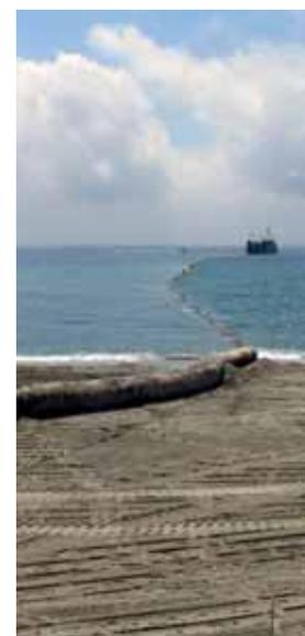
Scanno di Goro. Circa 124.000 metri cubi di sedimento sono stati trasferiti via mare per circa 4 chilometri con un sabbiodotto e distribuiti su un fronte di quasi 2,5 chilometri di spiagge in erosione. Tale modalità di trasferimento permette di contenere i tempi e il costo della sabbia portata a ripascimento.
