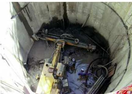
Perforazione di dreni sub-orizzontali all'interno di pozzi di grande diametro
