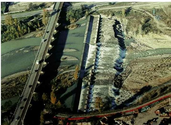
Anno 1994: la traversa di Veggia risulta vistosamente scalzata a valle per effetto dell'erosione che in breve tempo ne metterà a rischio la stabilità
