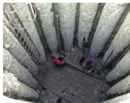
Roncofreddo: opere ingegneristiche speciali, interno di un pozzo drenante strutturale durante la costruzione
