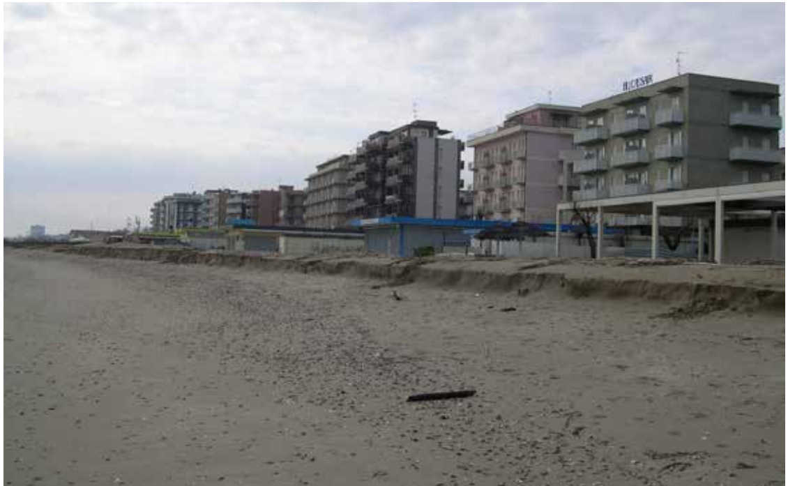
Figura 2.7. Abbassamento del piano di spiaggia e creazione di scarpata erosionale (Lido di Savio).
