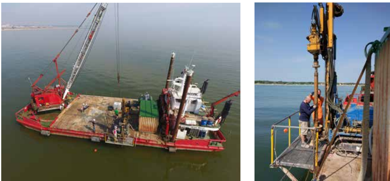
Figura 6.3. Immagini della campagna RER18, a sinistra foto da drone del motopontone allestito con gru, a destra il carotiere utilizzato per la campionatura del sedimento.
