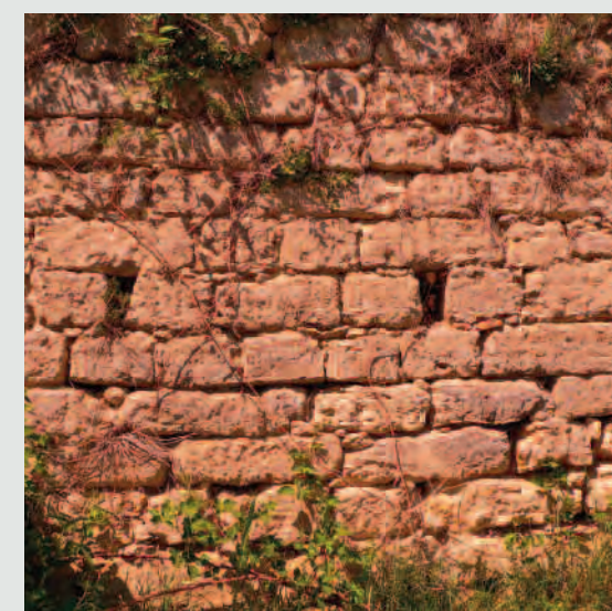
Muratura realizzata interamente con conci di spungone.
