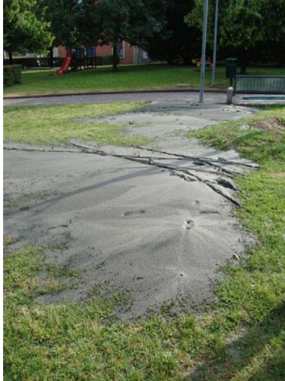
Foto 11.i. – Vulcanelli diffusi nei giardinetti di Corso Italia (nord della chiesa) lato sinistro adiacenti via Cavour.
