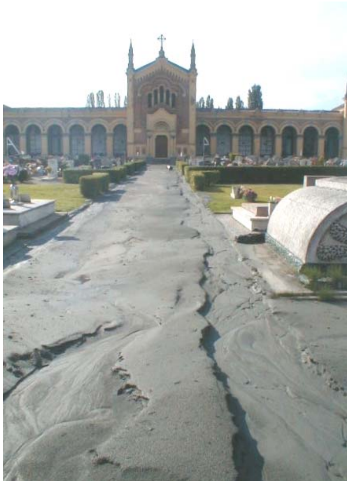
Foto 12o – Spaccatura nel terreno e rifluimento di sabbia nel cimitero di San Carlo , proseguimento delle spaccature della foto 12j e riportate in Figura 12.
