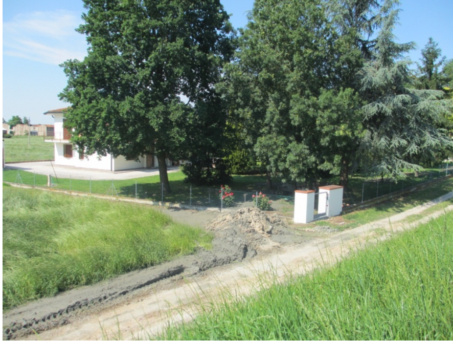
Foto 11.g – Abbondante rifluimento di sabbia nei campi sottostanti il lato campagna dell'argine sinistro (via argine postale) nella zona del campo sportivo di Mirabello
