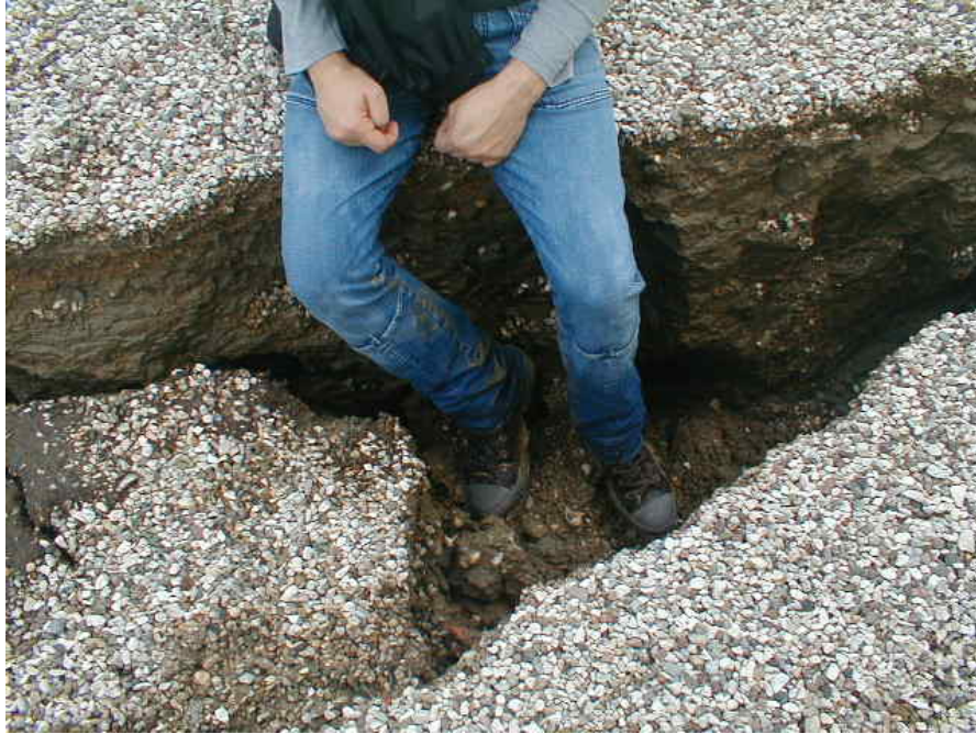
Foto 12k - Grossa spaccatura nel giardino di un'abitazione di Via Morandi a San Carlo proseguimento della serie di spaccature della foto 12.j.
