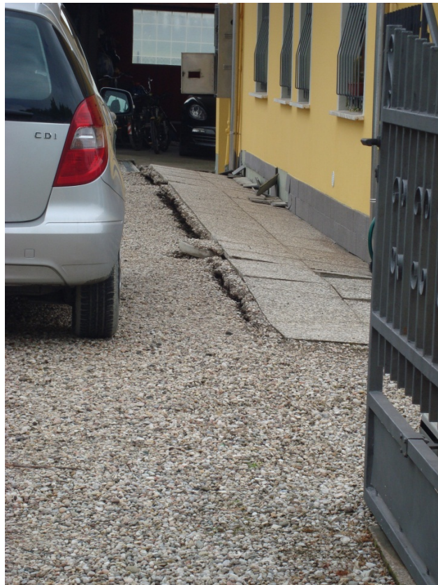
Foto 12l - Cedimento di fondazione di un edificio di Via Morandi a San Carlo proseguimento della serie di spaccature.
