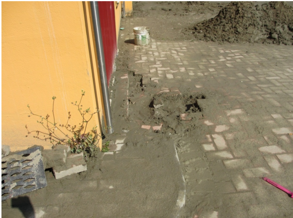
Foto 12d – Particolare della fuoriuscita di sabbia al n.c. 22 di Via Risorgimento, San Carlo
