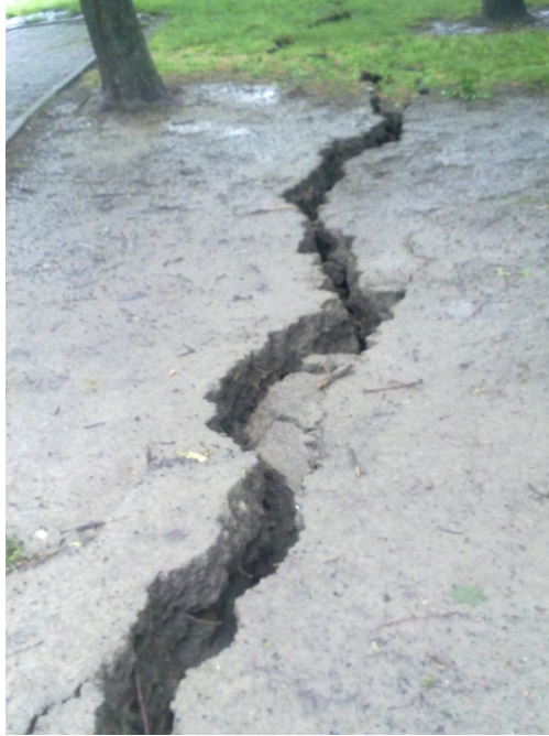
Foto 12l - Grossa serie di spaccature nei giardinetti adiacenti via Rossini, a San Carlo, proseguimento della serie di spaccature della foto 12.j.
