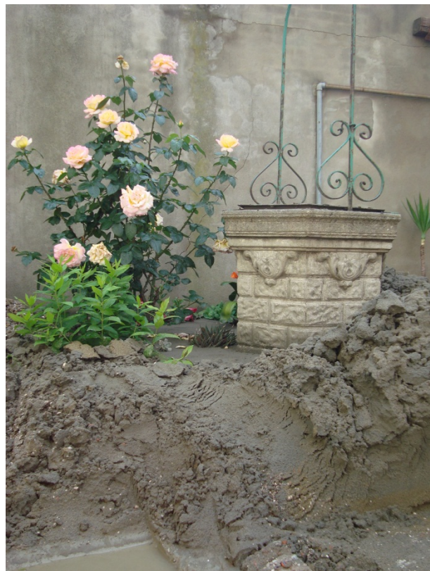
Foto 11.h – Abbondante fuoriuscita di sabbia da un pozzo di giardino interno, nel centro abitato di Mirabello (Corso Italia, sud della Chiesa, lato sinistro).
