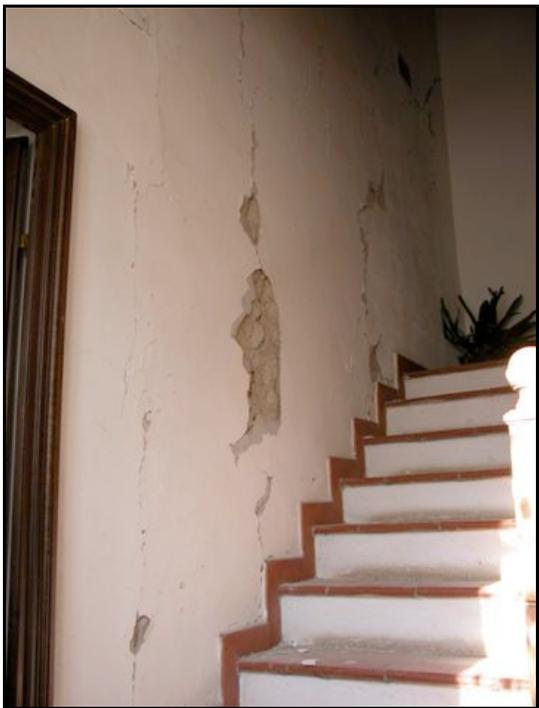
Foto n. 19 – San Vitale di B. (Sala Baganza): edificio privato, lesioni diffuse e distacco di intonaco
