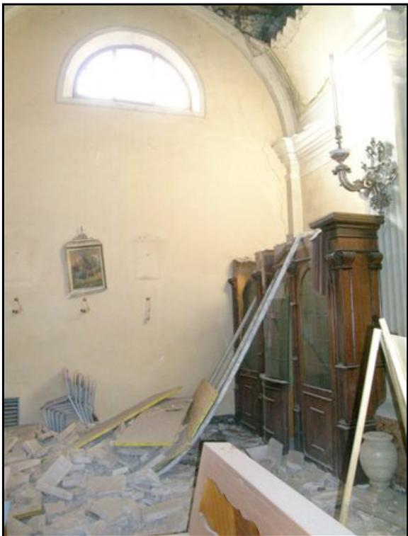
Foto n. 8 – Mamiano (Traversetolo): chiesa inagibile per crollo della volta in una cappella laterale
