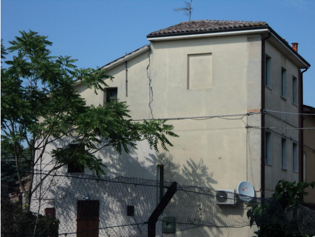
Danni a Mirabello
