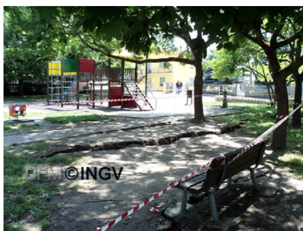
Foto 10. San Carlo. Effetti di liquefazione
