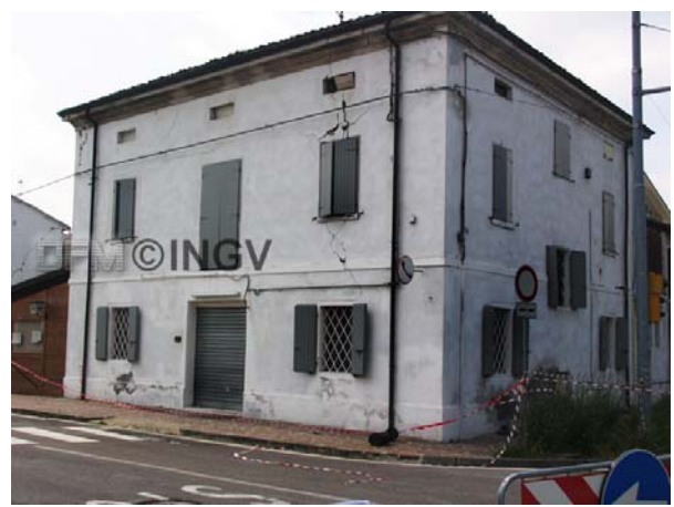
Foto 4. Fossoli. Crepe larghe e profonde. Danno di grado 3 in edificio di tipo B
