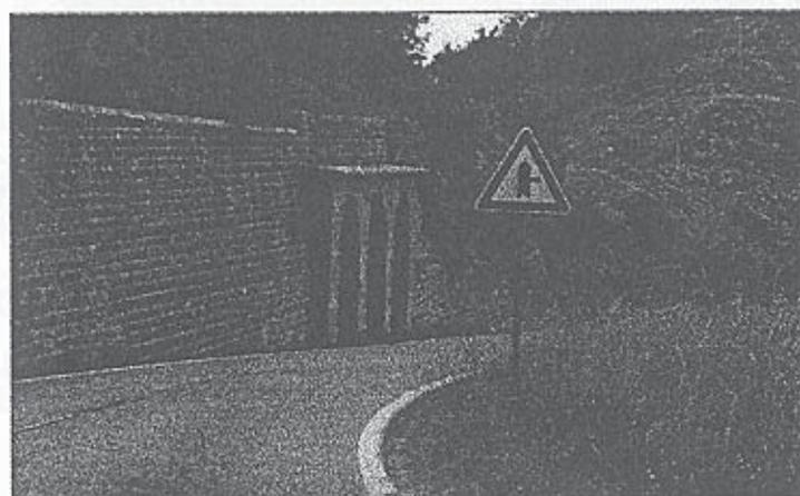
Sezione stradale con muro continuo e sostegno ad archi.
