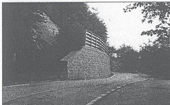
Sezione stradale con muro continuo, barriere di lamiera e reticolo paramassi.
