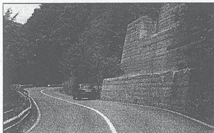
Sezione stradale con muro di contenimento gradonato in c.a. a faccia vista.
