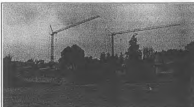
Lonnano: cantieri aperti
