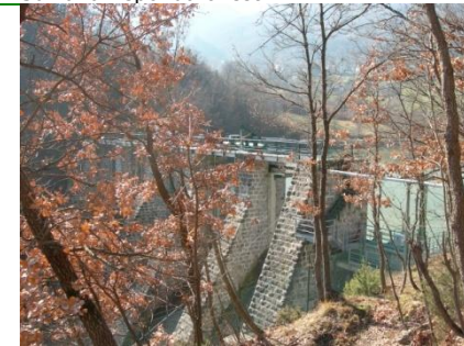
S. Damiano . diga
