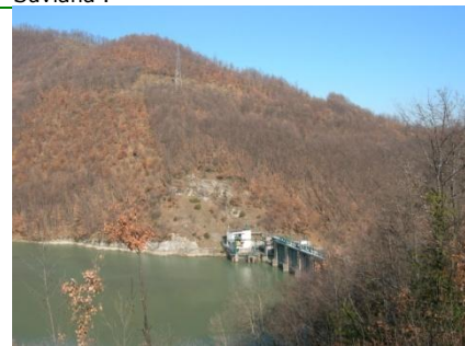
S. Damiano . versante a nord
