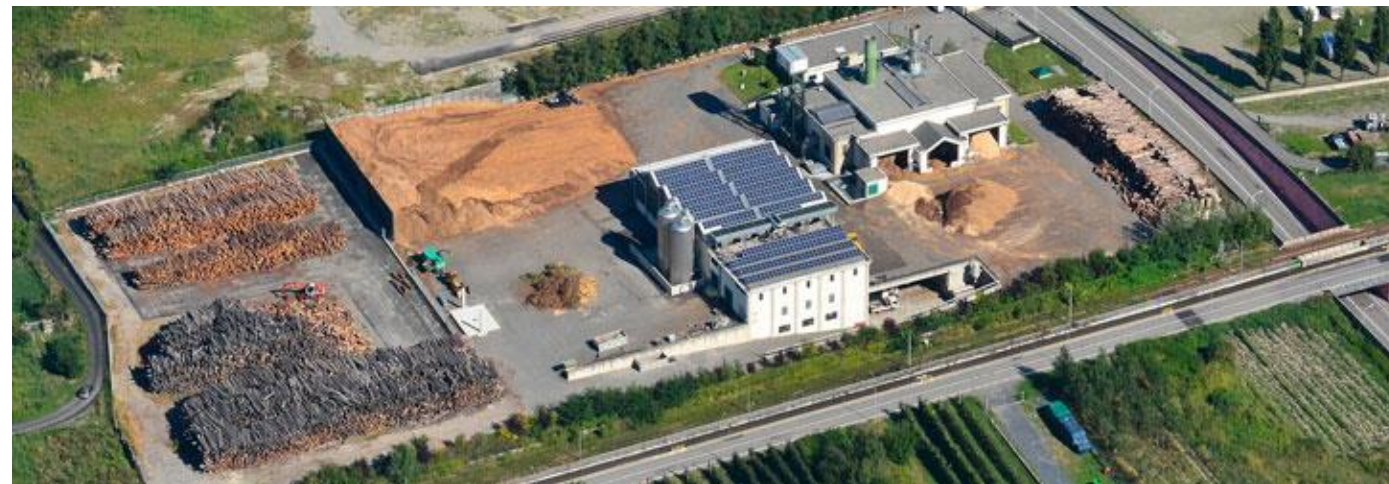
La centrale di TIRANO
