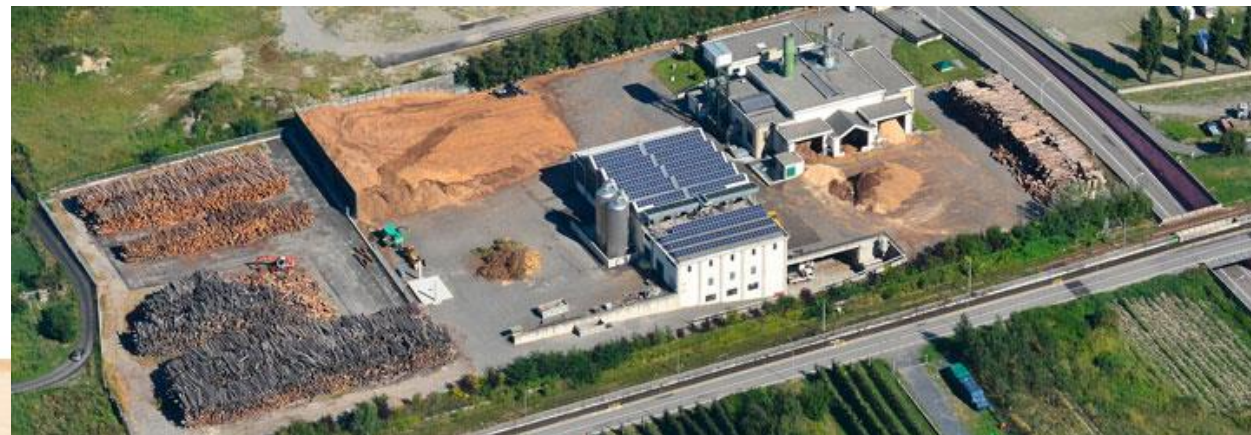
La centrale di TIRANO
