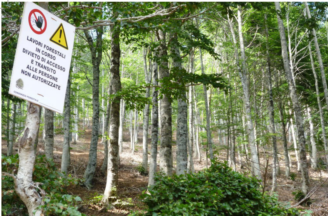
▼ Cantiere Forestale. Foto di R.Romano.
