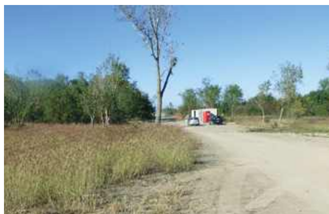
Confronto fra la zona con l'habitat 6210* integro, a sinistra, e l'area interferita dal cantiere di posa della condotta, sulla destra.
