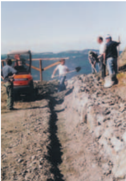
Operai al lavoro per la costruzione di solchi di drenaggio e muretti di contenimento nella vecchia area di cava.
