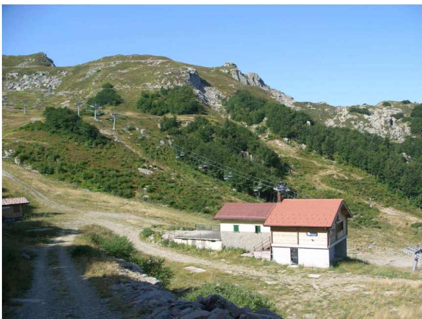
Figura 11 – Monte La Nuda, Rifugio presso stazione impianto di risalita
