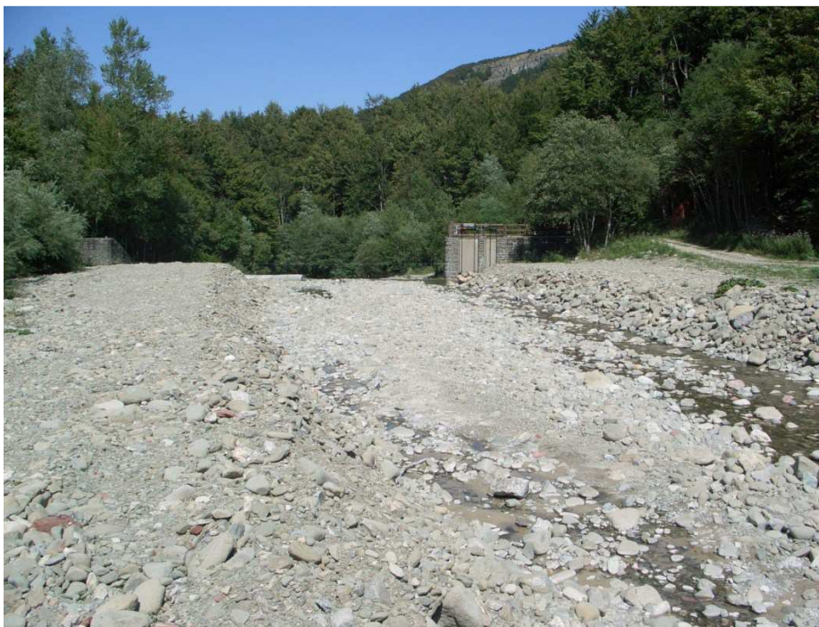
Figura 5 – Briglia con captazione di acqua superficiale sul torrente Riarbero all'altezza della loc. Le Ferriere (Sistema Acquedotto della Gabellina; cfr. Quadro Conoscitivo)
