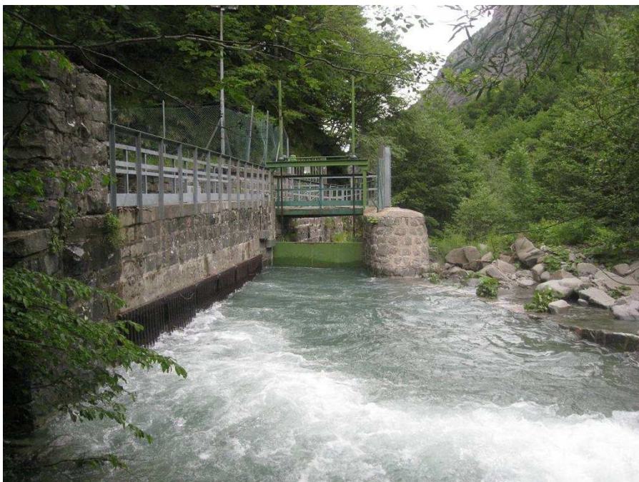
Figura 5 – Torrente Ozola, Presa Bassa
